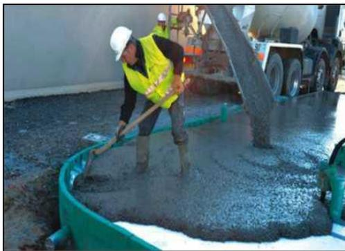
**Figure II.11:** Mise en œuvre d'un BAP [35].
