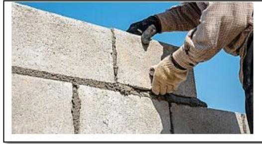
**Figure II.20:** Pose de mortier de hourdage [58].
