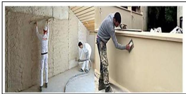
**Figure II.21:** Enduits isolants et enduits de façade. [58]
