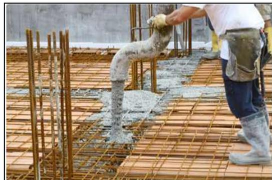
**Figure II.12 :** Application de béton autoplaçant sur des armatures [36].
