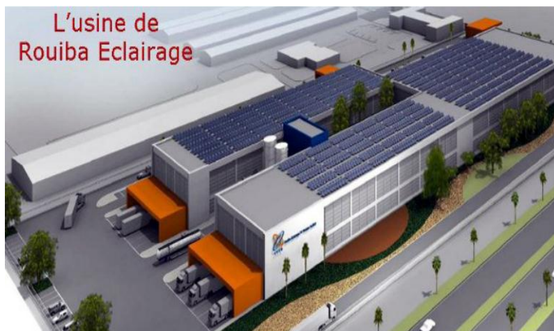
Figure I.6 : L'usine de Rouïba Eclairage[9].
