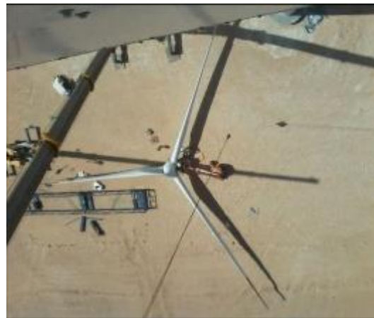
Figure IV.26 Finalisation montage du Rotor
