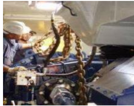
Figure IV.17 Insertion de l'outil d'élévation dans la nacelle à travers la trappe
