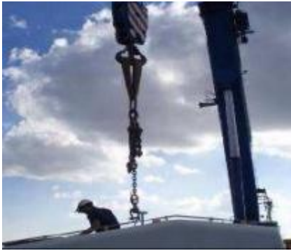
Figure IV.17 Insertion de l'outil d'élévation dans la nacelle à travers la trappe
