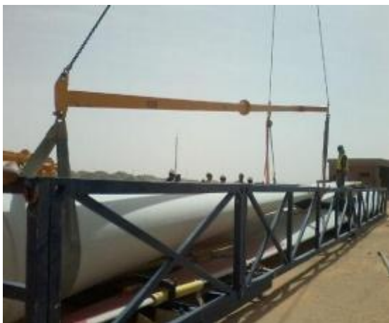
Figure IV.23 Levage et montage des pales
