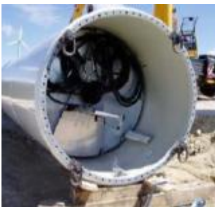
Figure IV.9 Détail Bride supérieure
