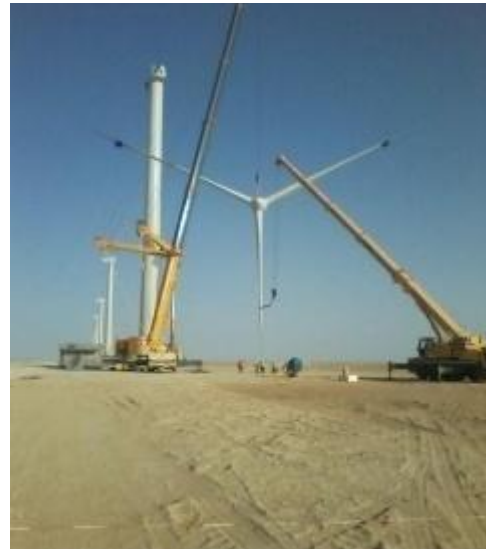
Figure IV.29 Levage et montage du Rotor
