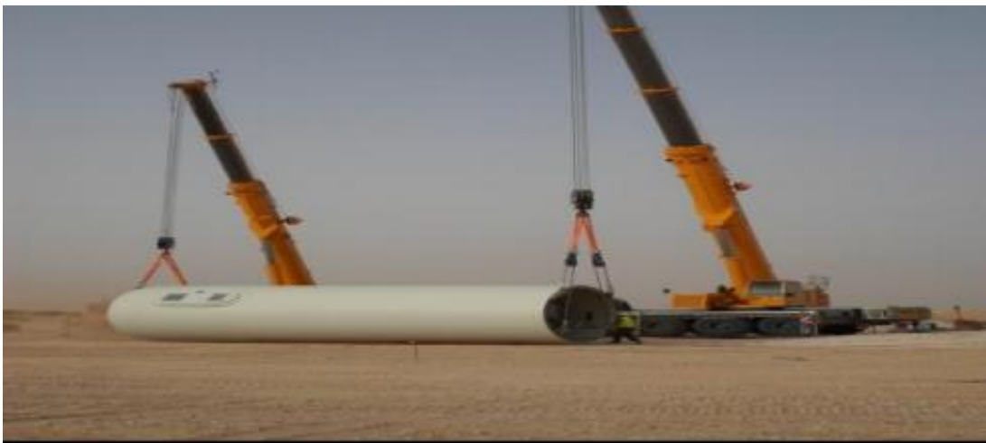
Figure IV.13 Levage de la section
