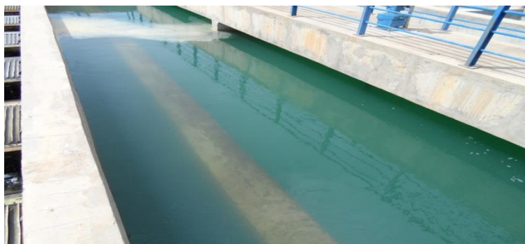
Figure.I.3 : Bassin de floculation.
