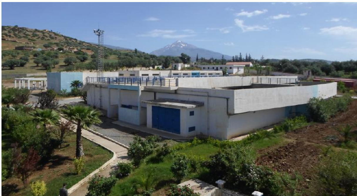
Figure.II.2. Vue de la station de traitement.
