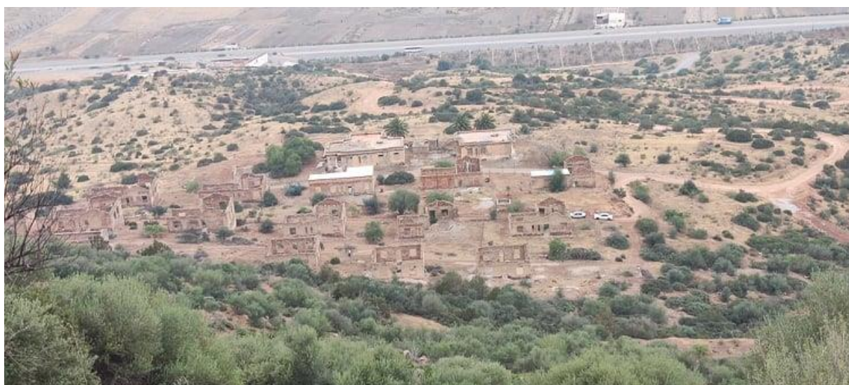
Figure I.15 : Direction et installations ouvrière
