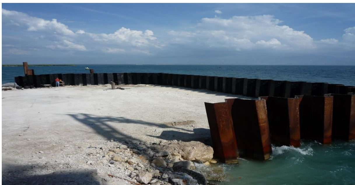
Figure I.7 : Qui en palplanches métalliques.
