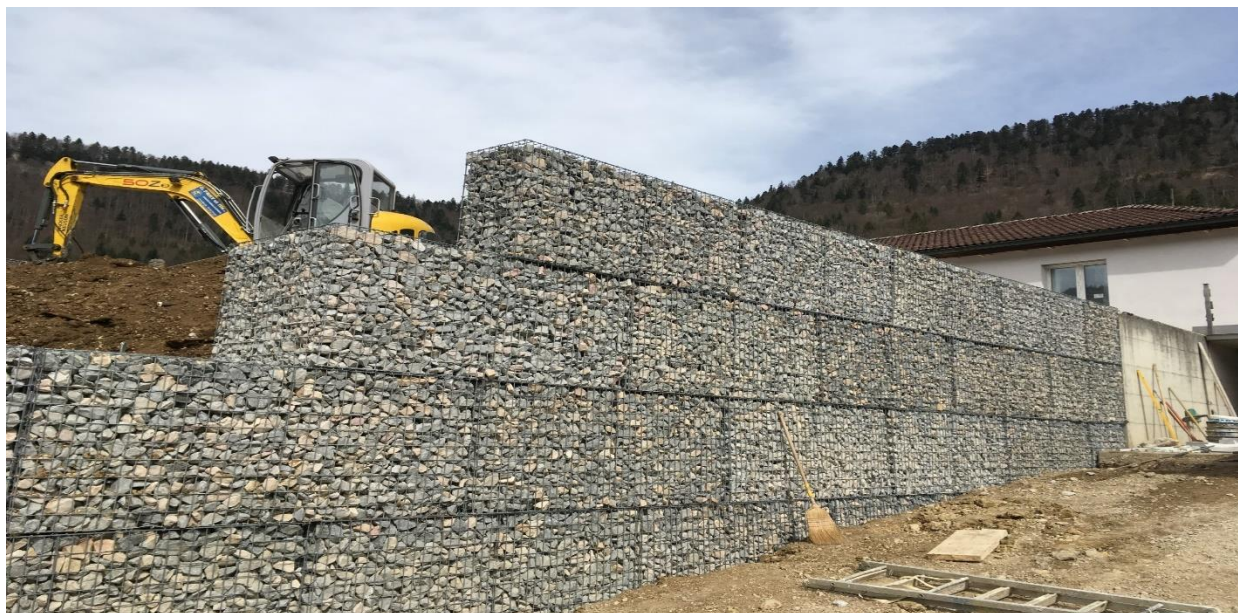
Figure I.5 : mur de soutènement en gabion.
