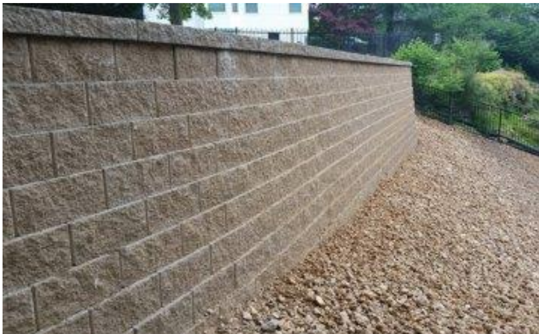
Figure I.4 : ouvrage de soutènement en maçonnerie
