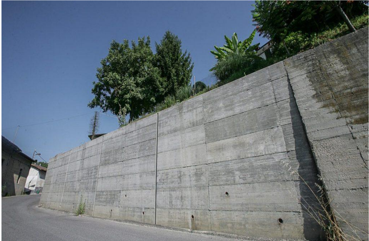
Figure I.3 : mur de soutènement en béton armé.
