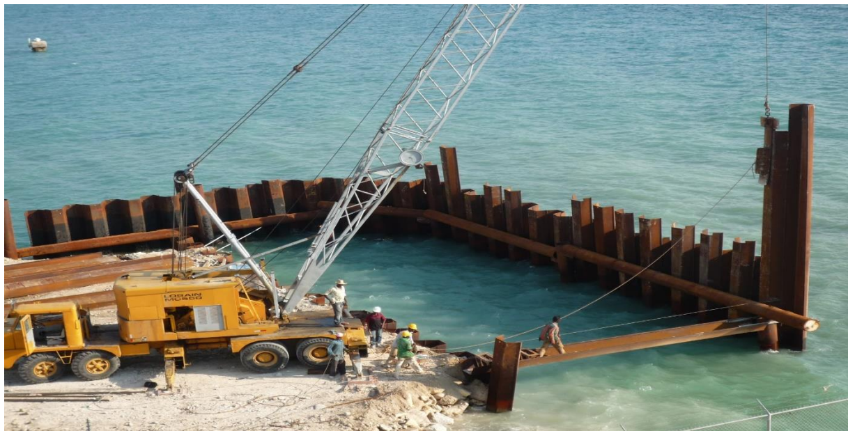
Figure I.6 : Qui en palplanches métalliques.
