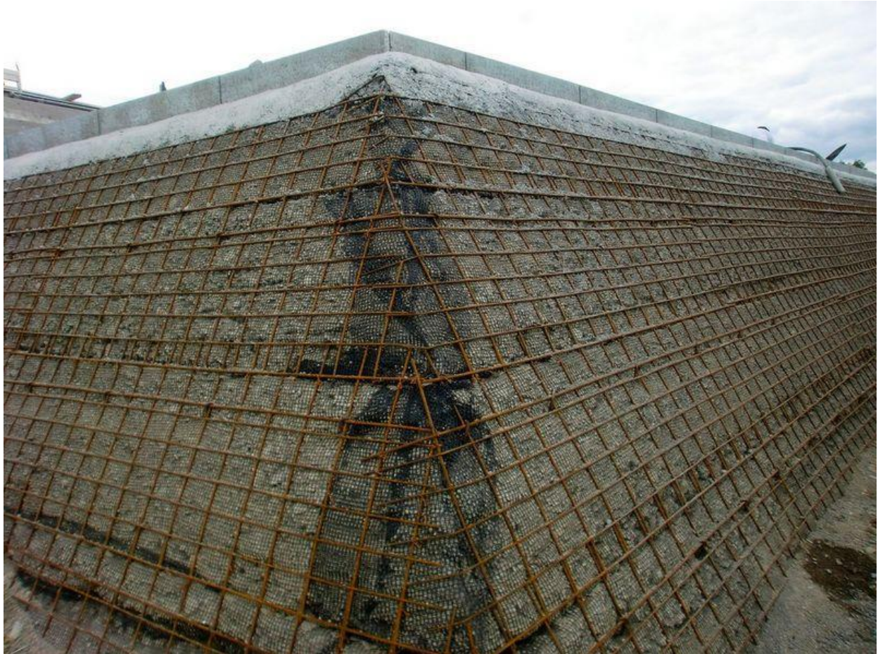
Figure I.8 : mur de soutènement en terre armée
