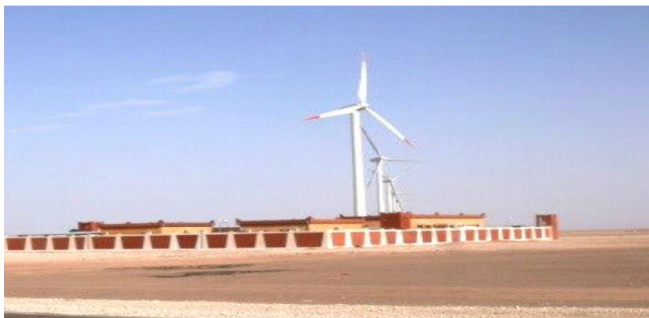
Figure III.17. Ferme éolienne 10MW
