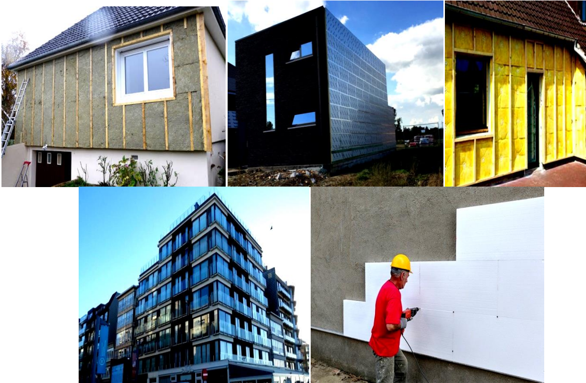
Figure II.17. Les différents types d’isolation extérieure
