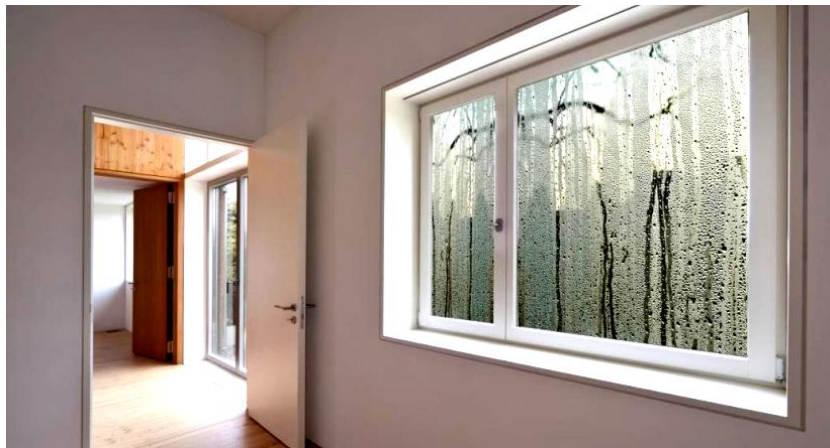
Figure II.5. Exemple sur la condensation
