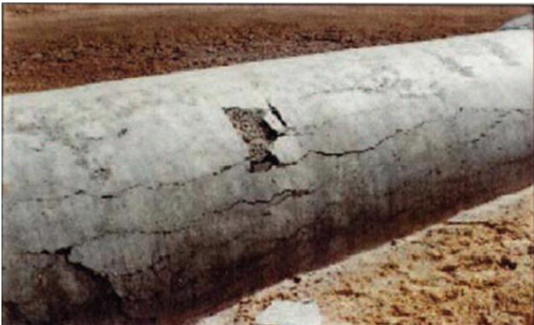
Figure III.8 : Canalisation dégradée [17].
