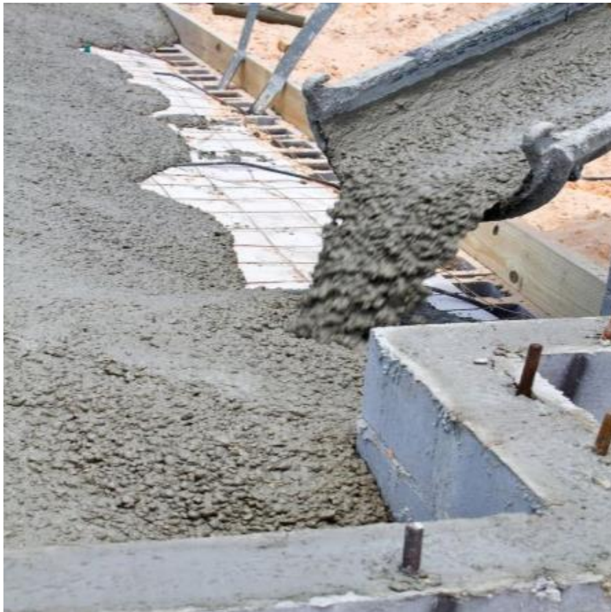
Figure II.2 : Coulage de béton sablé [16].
