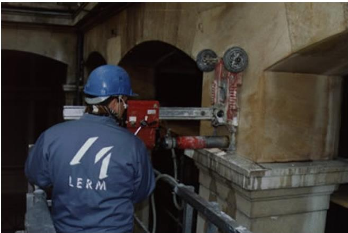
Figure IV.12: Carottage électrique à la couronne diamantée de 20 à 110 mm de diamètre[24]
