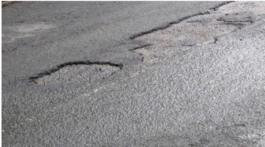
Figure II.4 Exemple d'une pelade.
