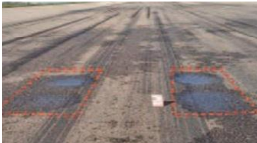
Figure II.12 Exemple d'un poinçonnement .
