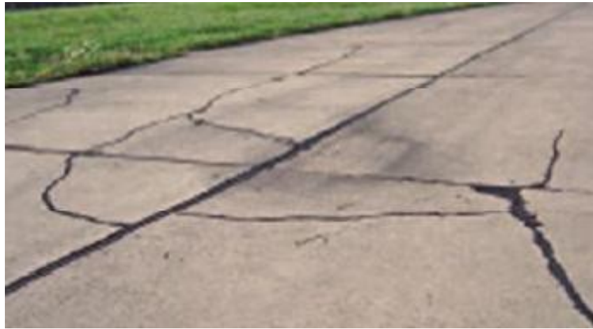
Figure II.17 Exemple d'un pompage.
