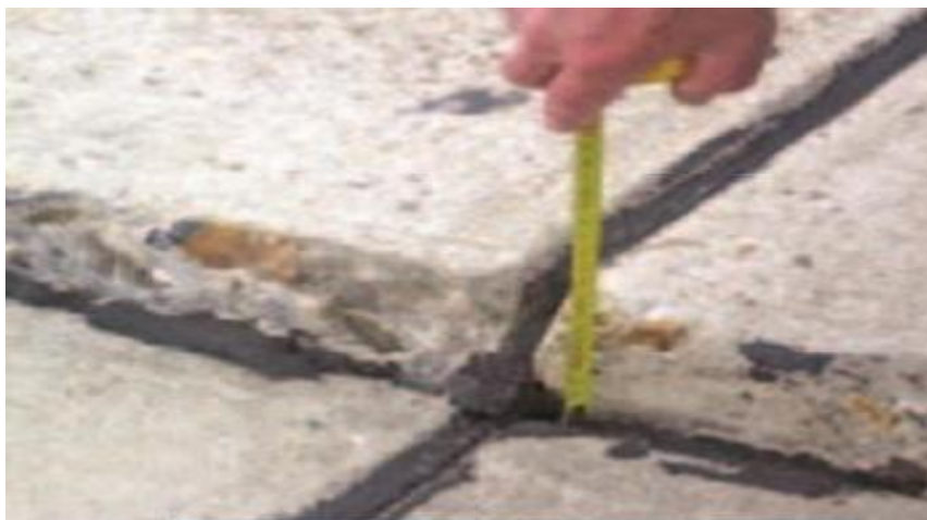
Figure II.18 Exemple d'un décalage.
