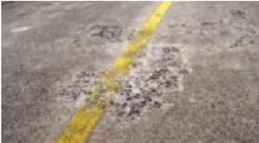
Figure II.20 Exemple d'un écaillage.
