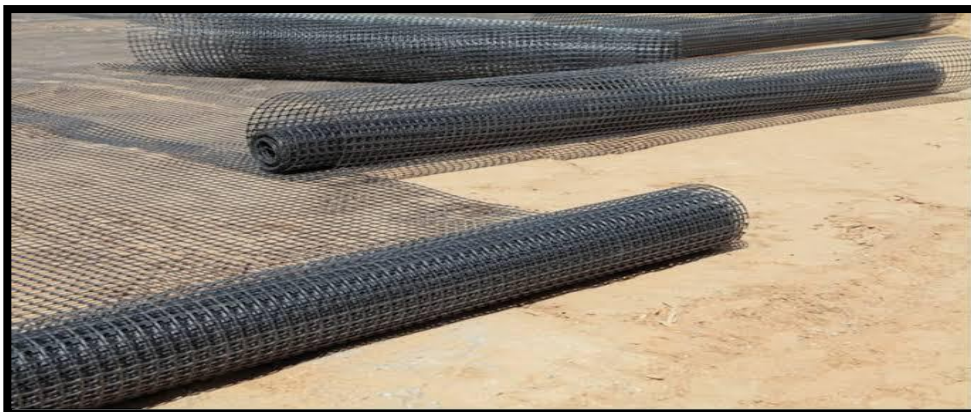
Figure IV.11 Illustration d'une nappe de Géogridde
