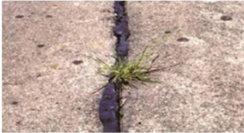
Figure II.21 Exemple d'une éjection du joint
