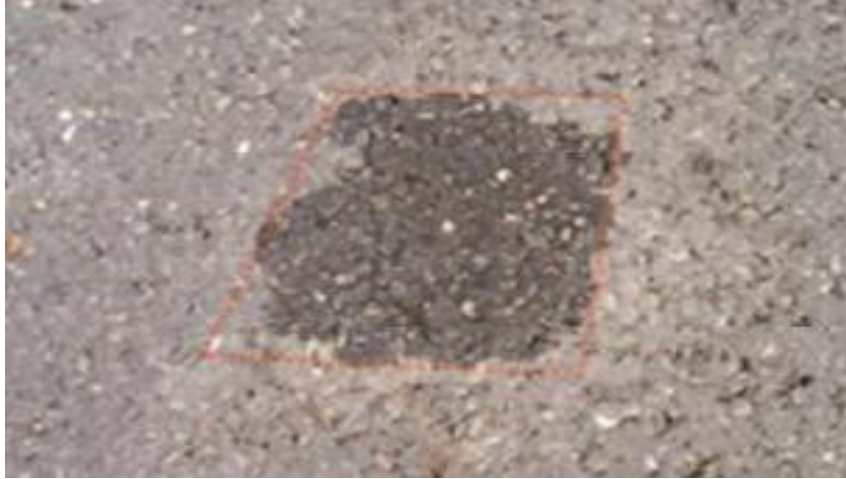
Figure II.14 Exemple d'une remontée d'eau.
