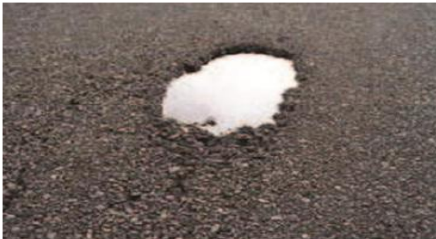
Figure II.5 Exemple d'un nid de poule.
