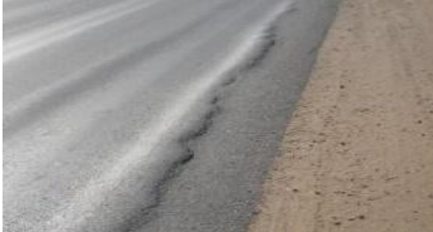
Figure II.10 Exemple d'un bourrelet.
