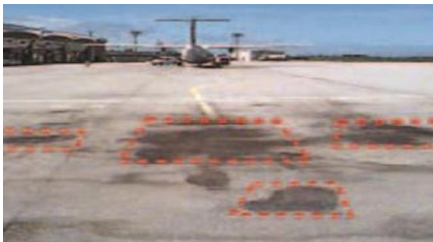
Figure II.13 Exemple d'une contamination.
