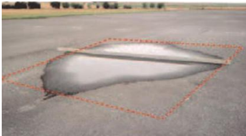
Figure II.7 Exemple d'une flache.
