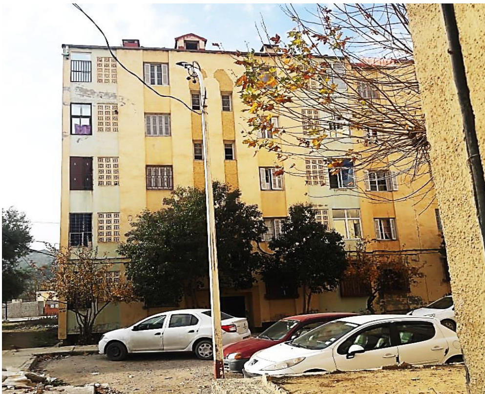
Figure IV.3. Photo du bâtiment étudié
