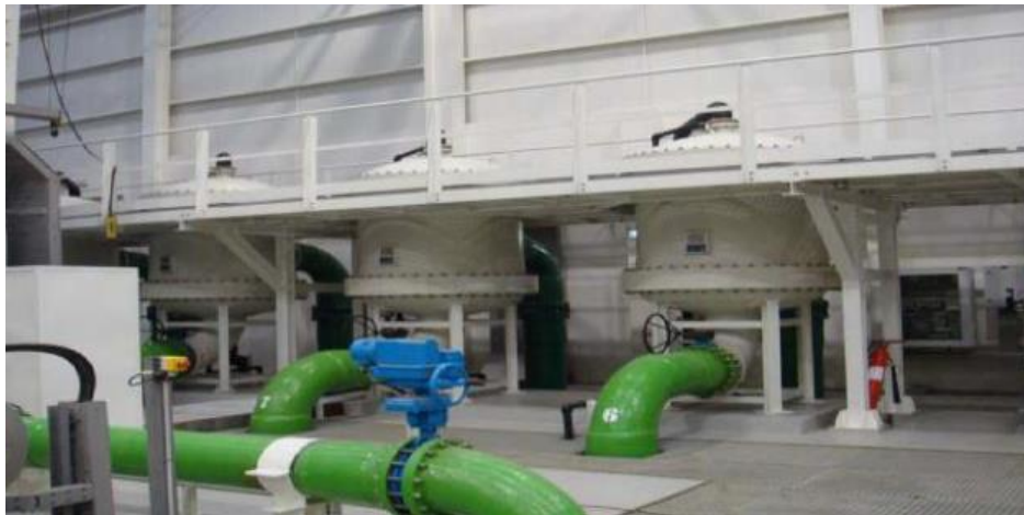
Figure 23 : Filtres à cartouches
