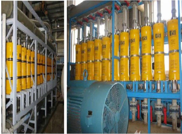
Figure 25 : Echangeur de pression ERI
