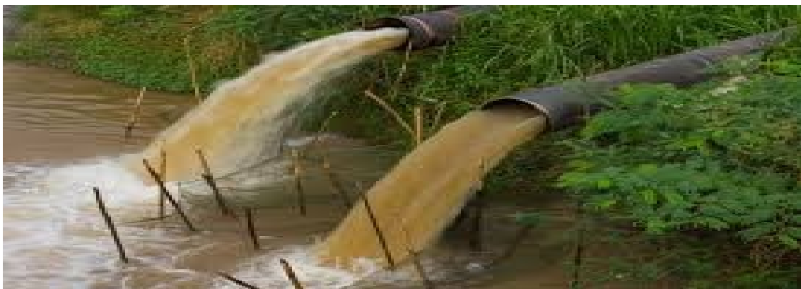
Figure I.1: Déversement des eaux usées
