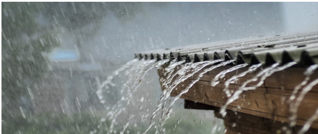
Figure I.4: Les eaux pluviales
