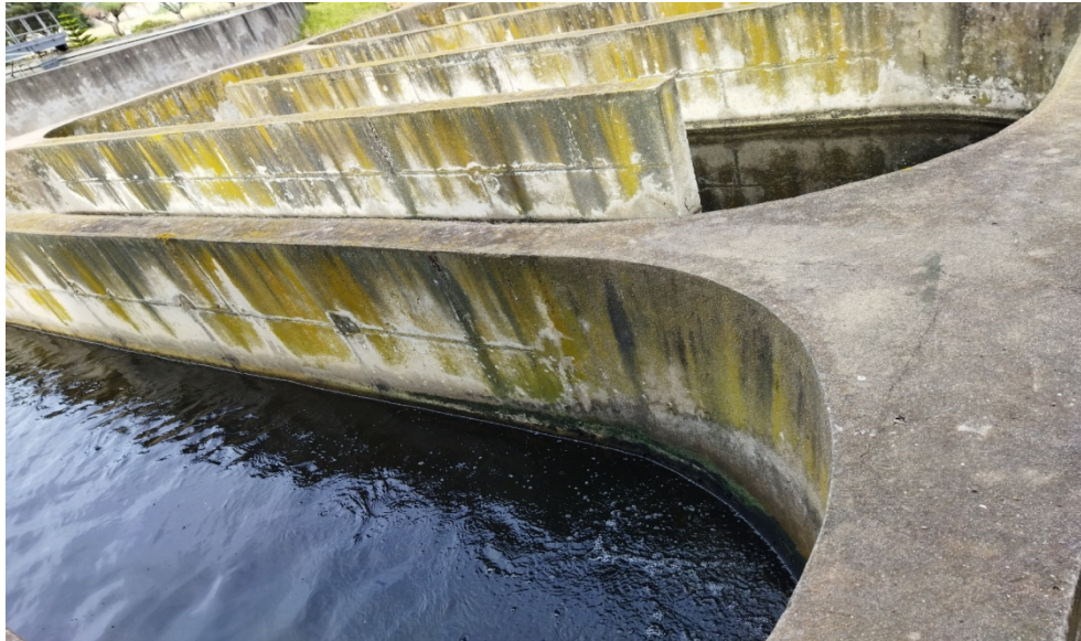
Figure II.10: Les bassins de désinfection
