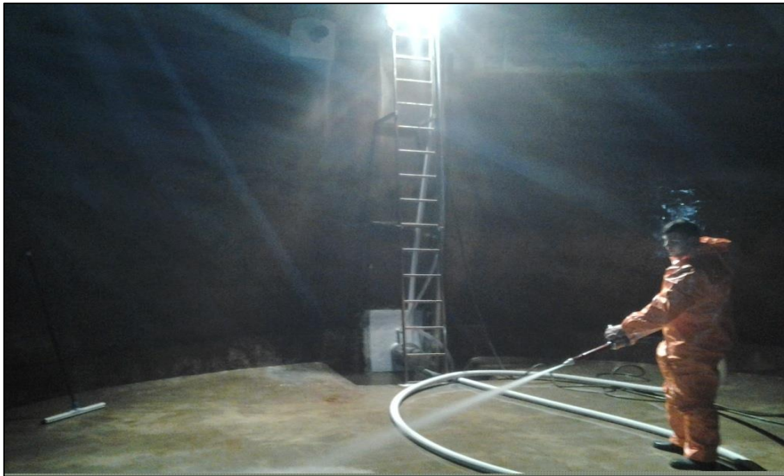
Figure II.2: opération de nettoyage d'un réservoir.
