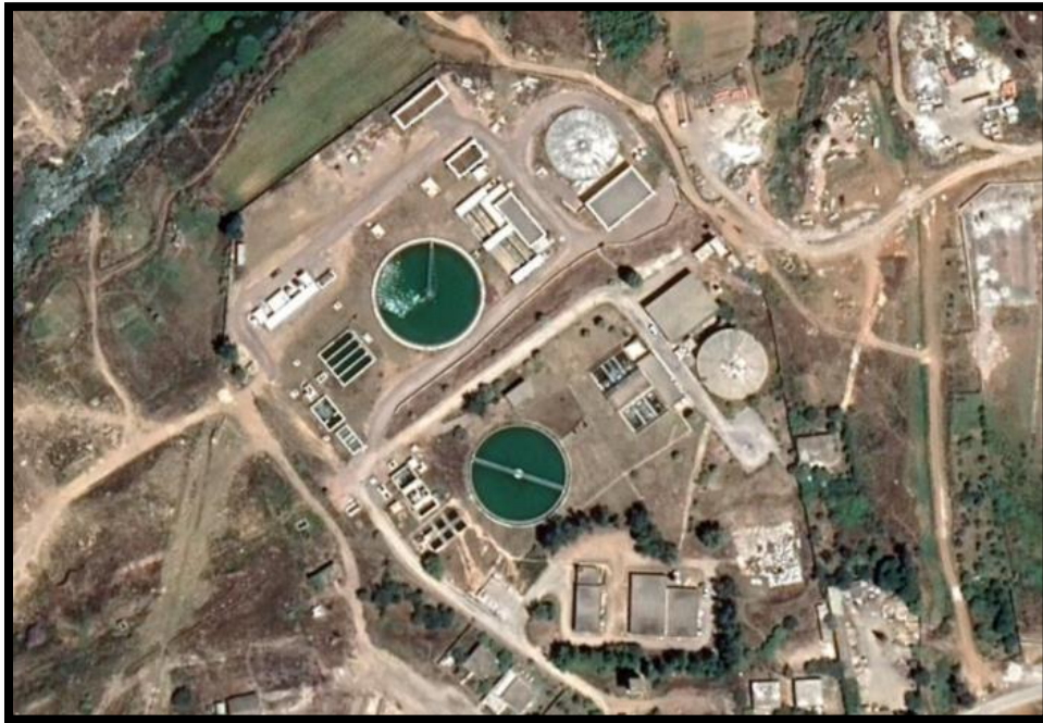
Figure III.3 : Photo satellitaire de la station de traitement des eaux brutes du barrage de Hammam Debagh (Google Earth, 2020).
