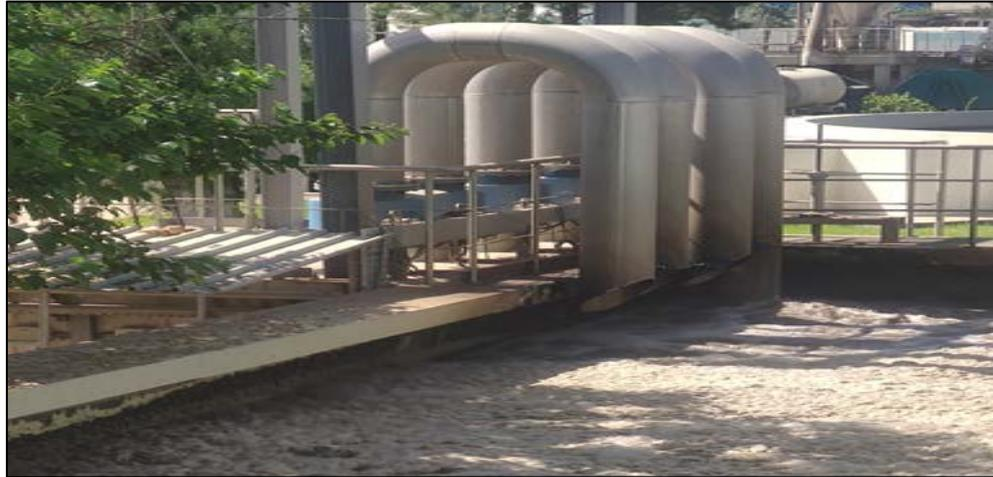
**Figure II. 10:** Poste de recirculation de boue biologique
