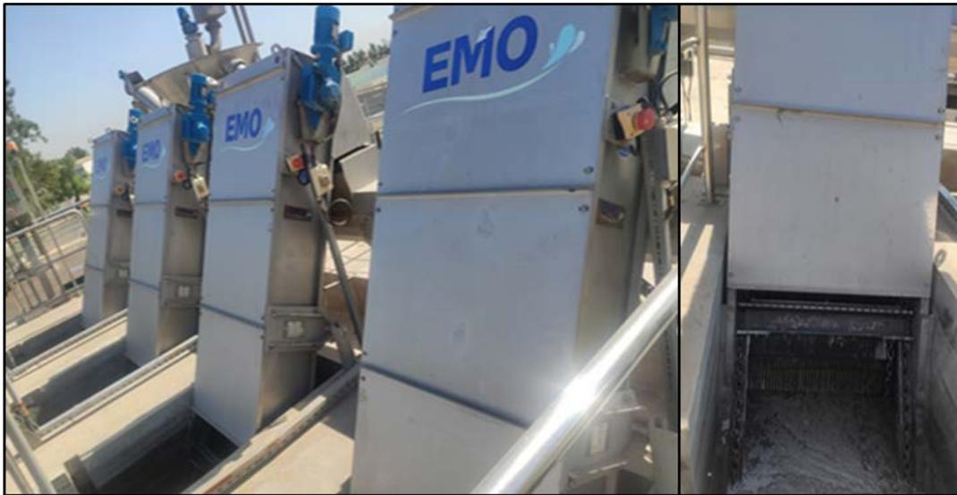
**Figure II. 3:** Dégrilleurs automatiques
