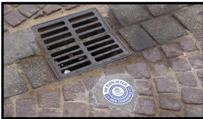
Figure 11. Bouche d'égout (google, s.d.)
