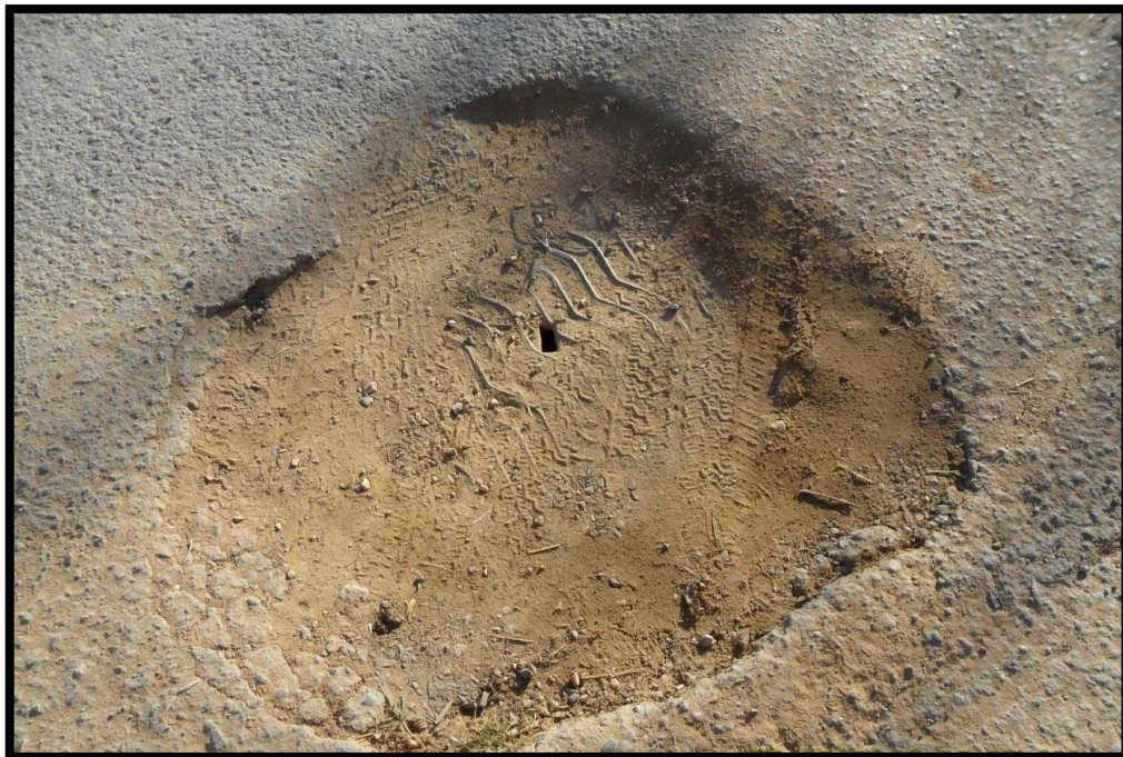
Figure 19. Ouverture impossible de ce regard (Image )
