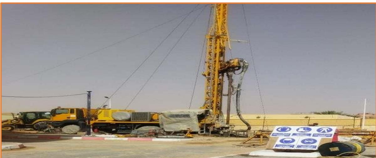
*Figure 13 : le mat de l'appareil de forage (Forage piscine Hassi Messaoud).*
