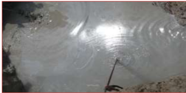
Figure 38: Préparation le lait de ciment
