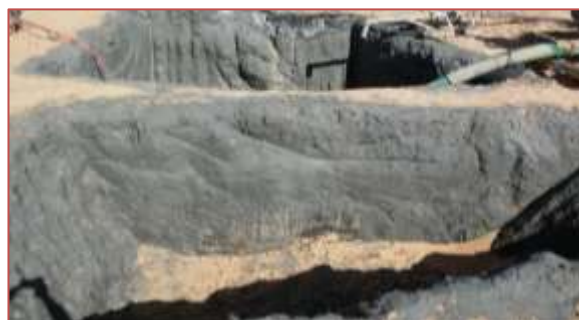
Figure 34 : Les fosses à boue du forage de Djendel
