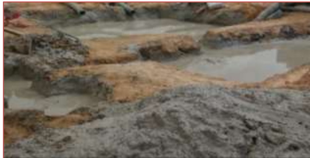
Figure 43 : Lavage de puits
