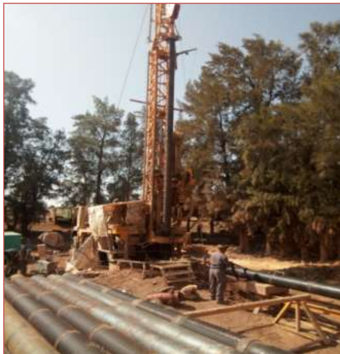
Figure 42: Mise en place du tubage et crépine du forage de Djendel
