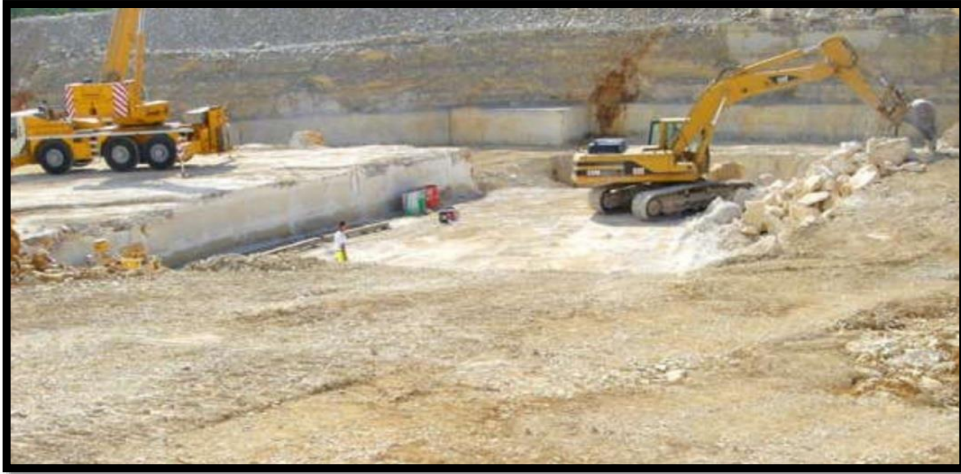
Figure II. 9. Le pelletage mécanique
