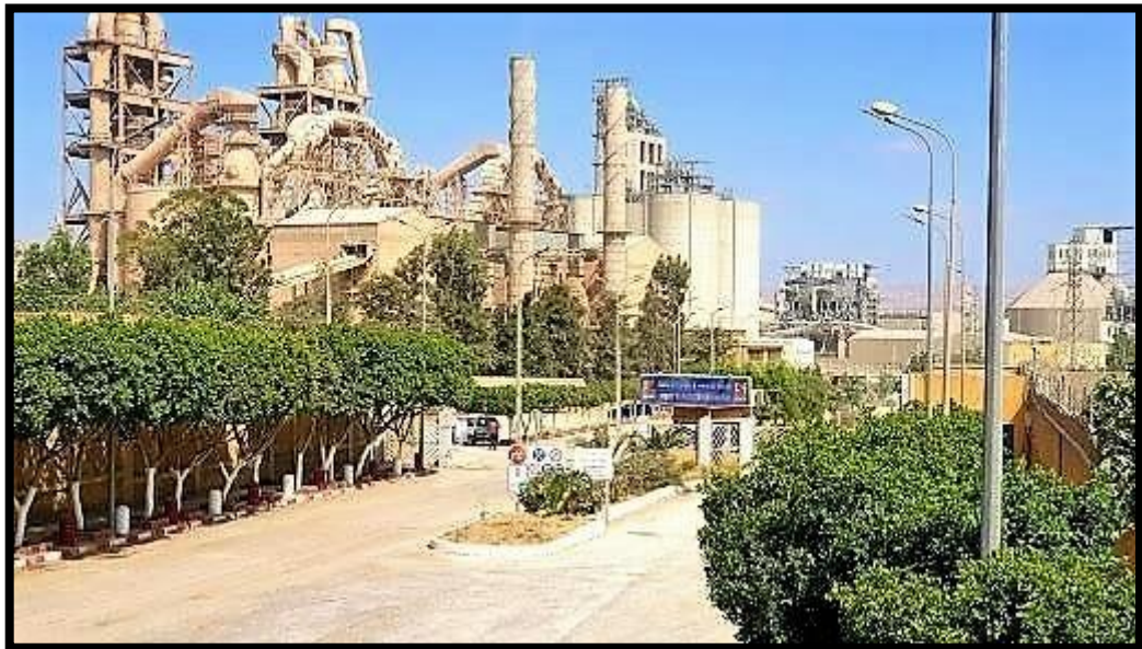
Figure I. 1. Société des ciments ECDE CHLEF
