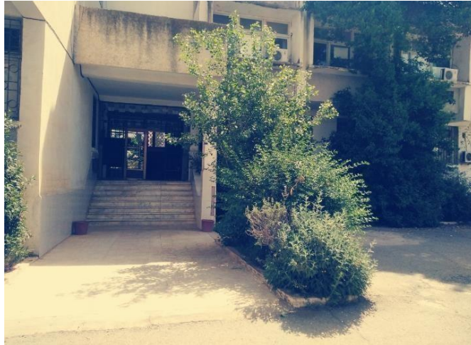
Figure (I.3) : SETAM agence de BOUIRA (entrée principale)
