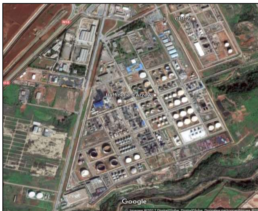
Figure II. 1: Complexe de la raffinerie par satellite
