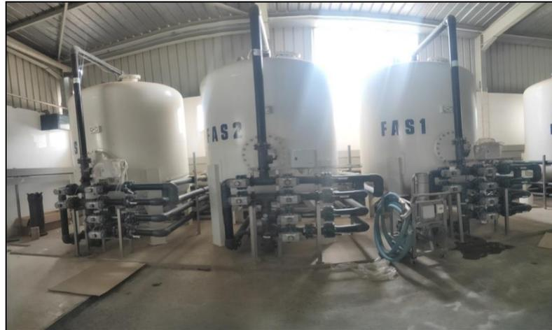
*Figure III.4: Filtres à sable*
