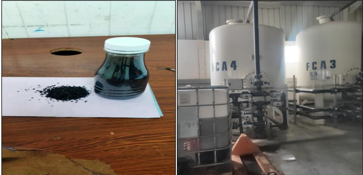
*Figure III.5: Charbon active et Filtres à charbon active*
