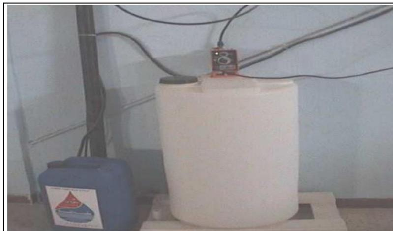
*Figure III.2: Réservoir l'eau de javel*
