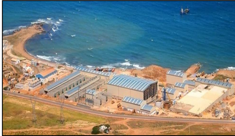
Figure I. 2: Vue générale sur la station de Ténès
