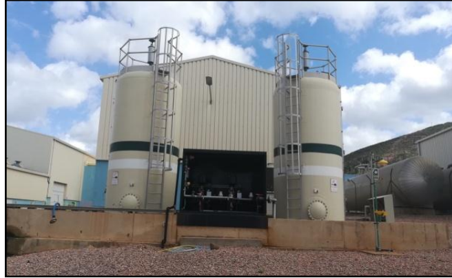
Figure III. 11: Silos de stockage d'hypochlorite de sodium
