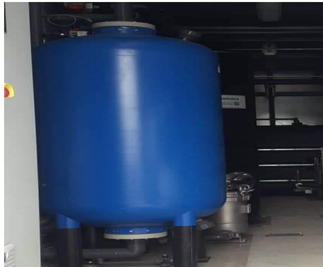
Figure III.7 : filtre à sable.
