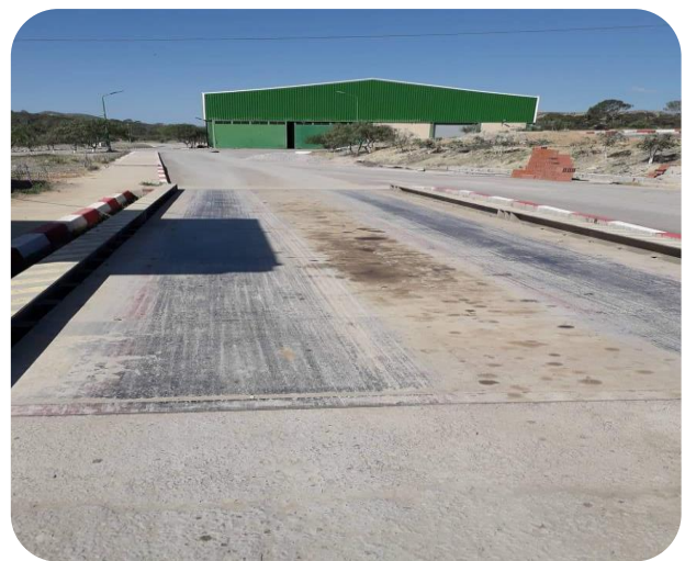
Figure I.6: Pont bascule de passage des déchets (CET AHNIF).
