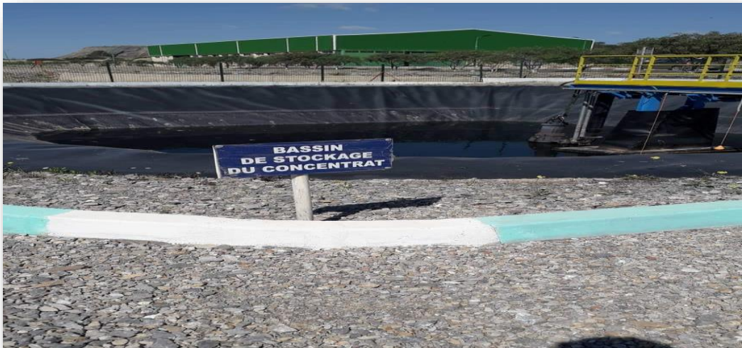
Figure I.9: Bassin de stockage du concentrât.
