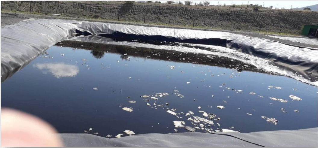
Figure I.8 : Bassin de lagunage.
