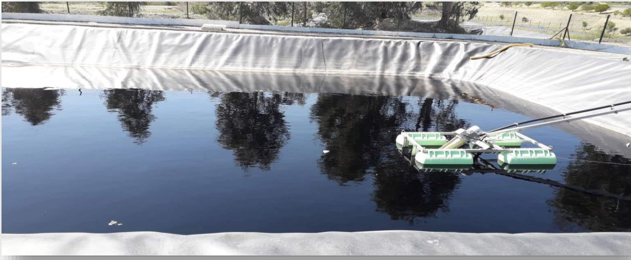
Figure I.7 : Bassin d'homogénéisation.
