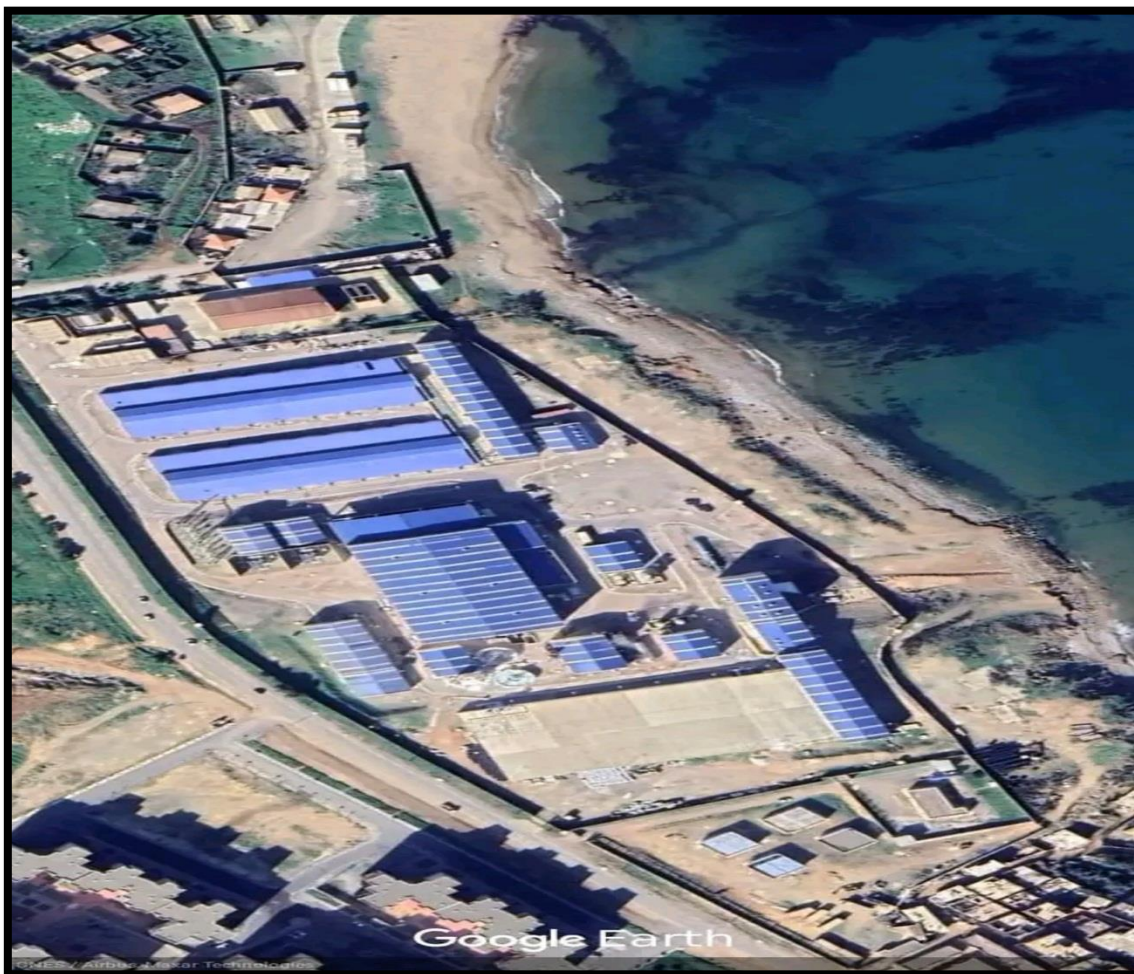
Figure 2 : Vue générale sur la station de Ténès
