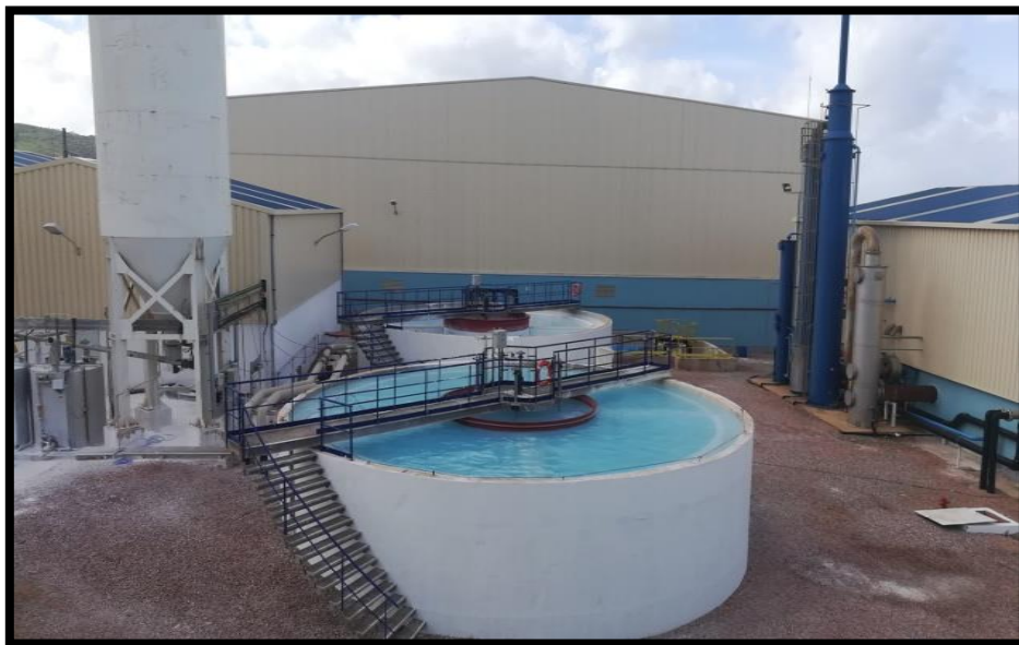
Figure 14: Système de saturation de chaux du \text{CaCO}_3
