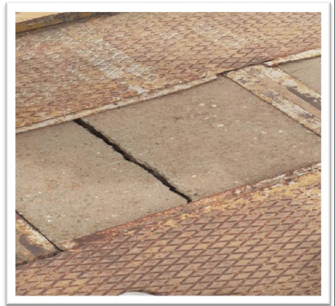
Figure II.2 Décrochement N°3 sur la tour de prise
