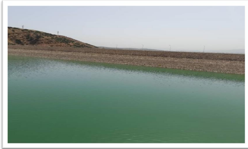
Figure II.6. Enrochement de la digue (16/05/2022)
