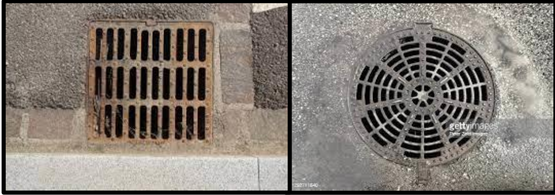
Figure 12 : Bouches d'égout (Google, s.d.)
