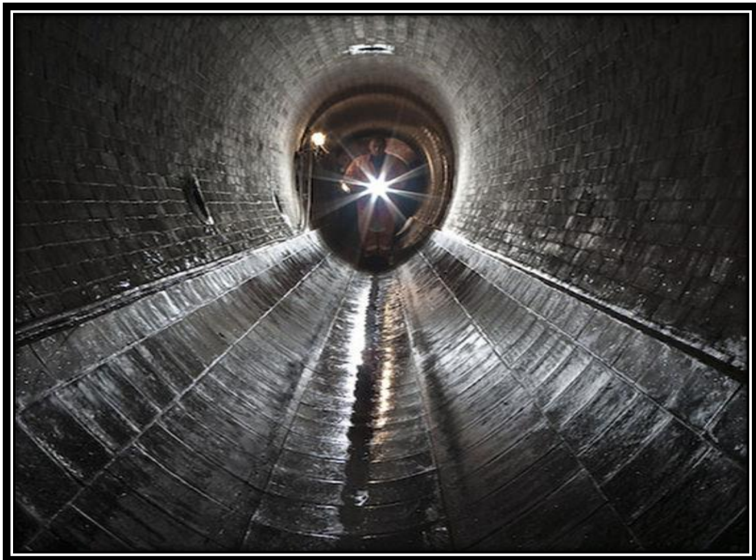
Figure 10 : Canalisation ovoïde (Google, s.d.)
