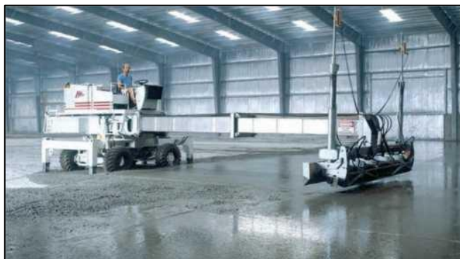
Figure II.5 – utilisation des fibres métalliques dans les dallages industriels
