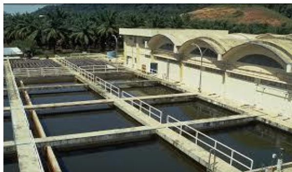
Figure I.6 : Bassins de filtration.
