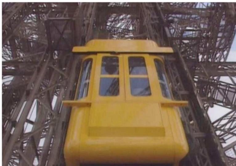
Figure I.3 : Ascenseur de la tour Eiffel.[5]
