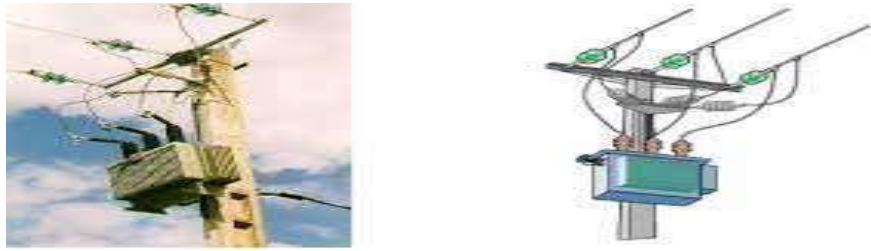
Figure I.9. Poste de transformateur de haut poteau [3]
