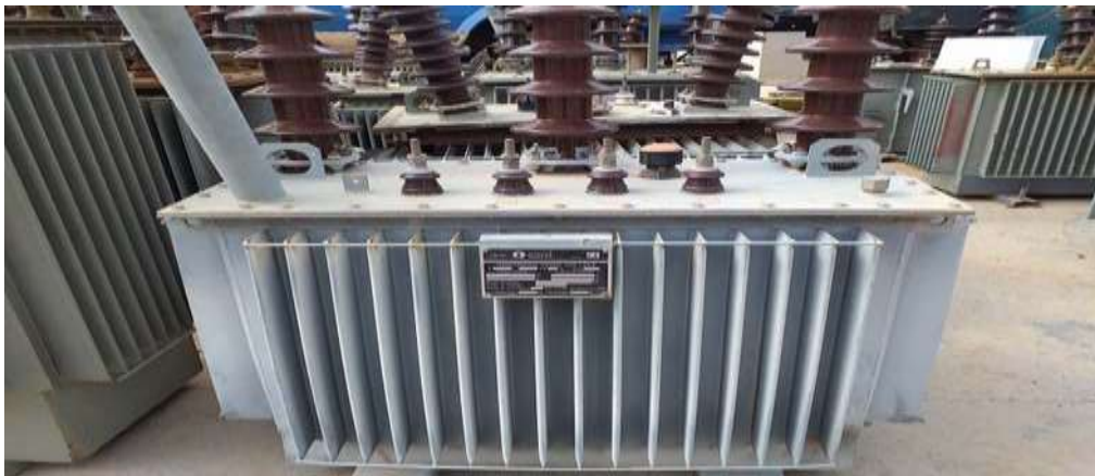
Figure III.15. Transformateur électrique
