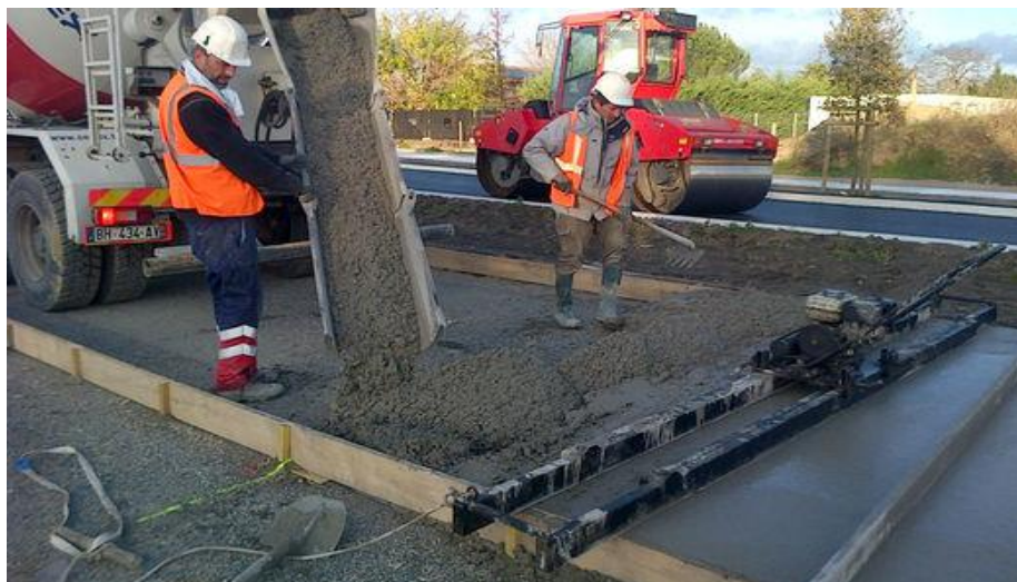
Figure I.11 : Route en béton
