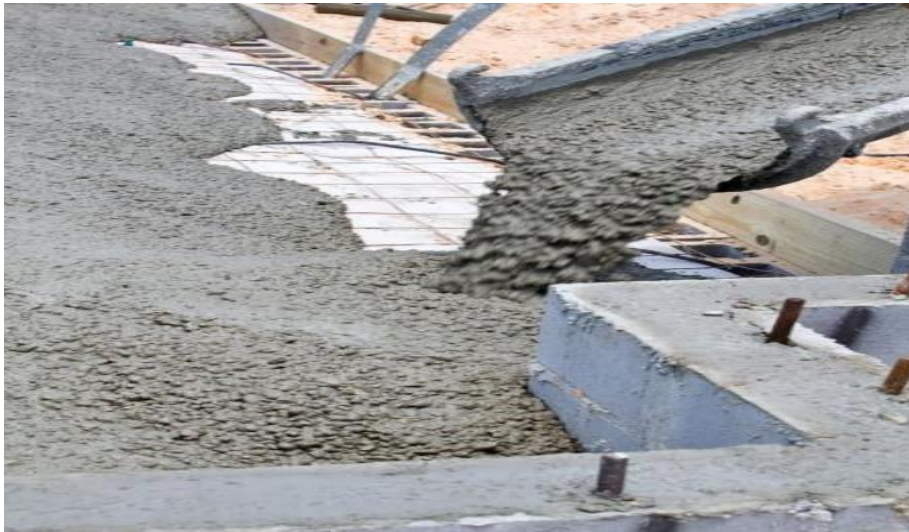
Figure 1.5 : Coulage de béton sablé
