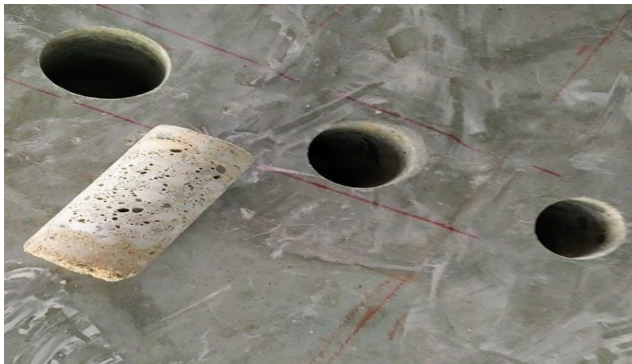
Figure II.3 : Méthode destructive (Carottage de béton)
