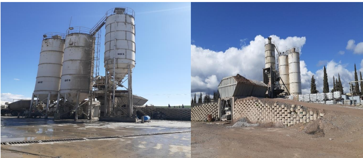
Figure II.1 : Central à béton TAMRAF
