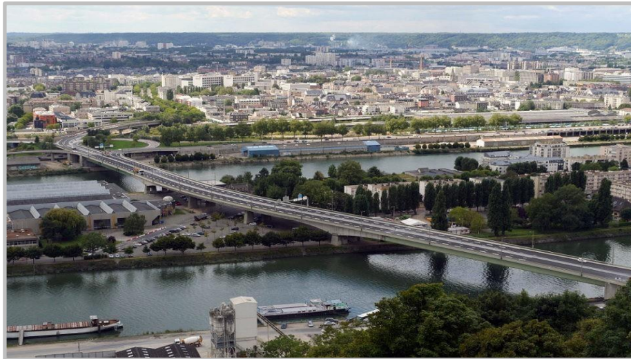
Figure I.10 : Pont-Mathilde (France) 584,7 (m) en béton.
