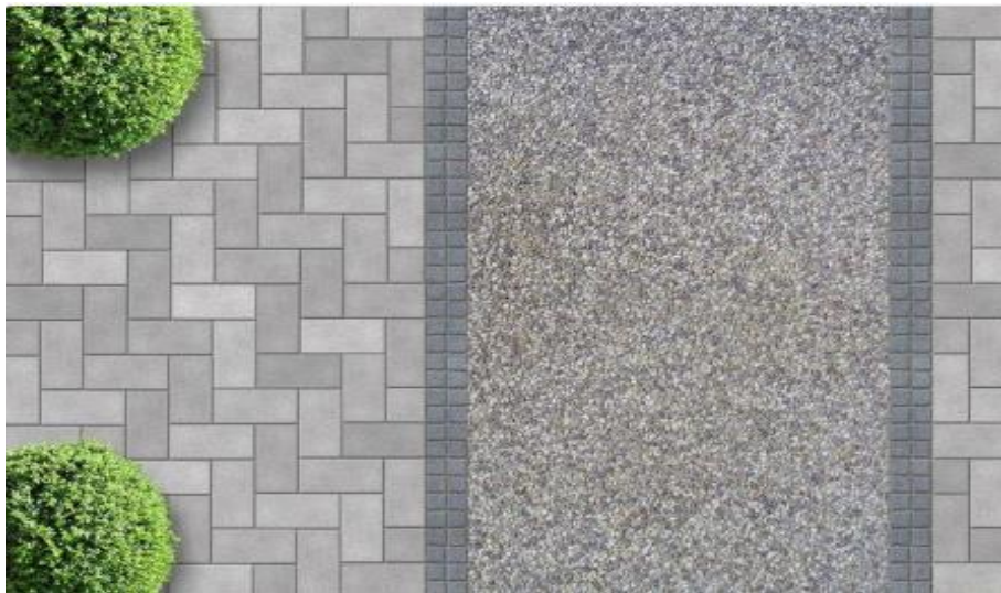
Figure I.7 : Voie en béton lavé
