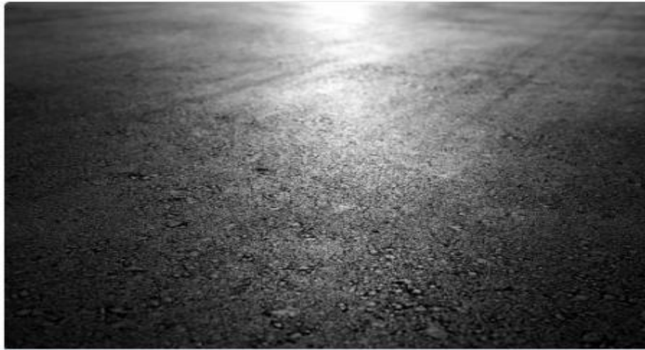
Figure I.8 : Sol en béton bitumineux
