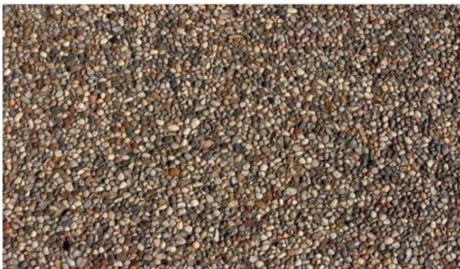
Figure 1.6 : Terrasse en béton désactive
