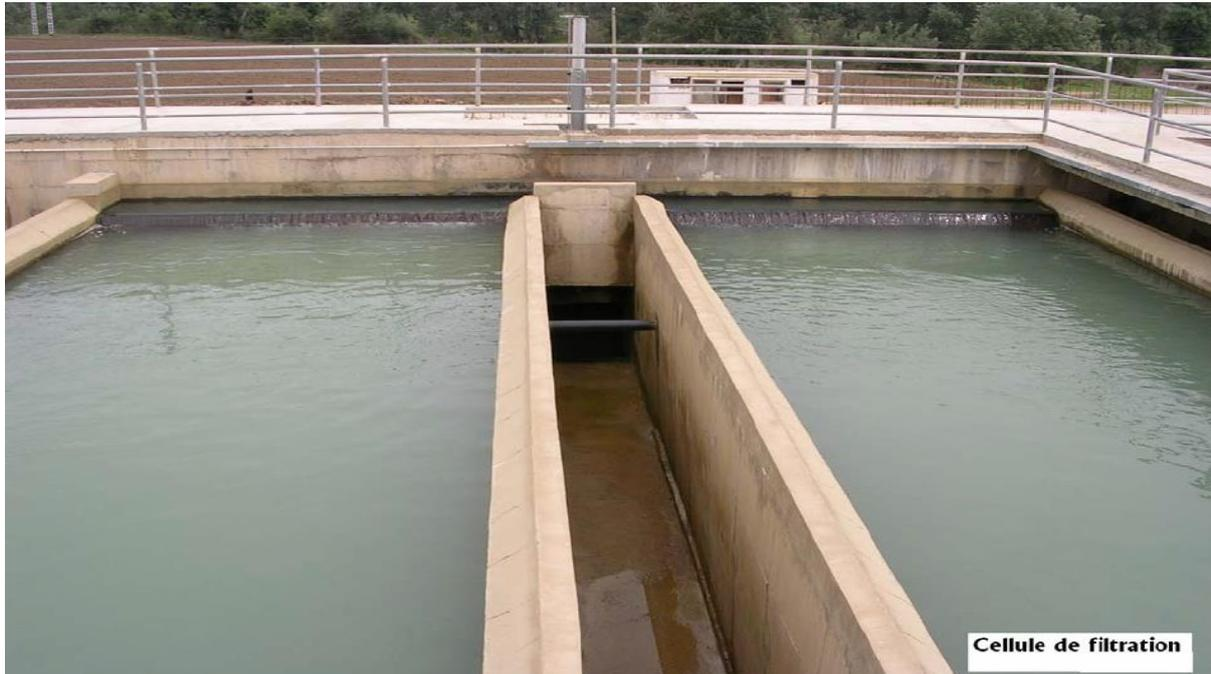
Figure 0-6: Cellule de filtration.
