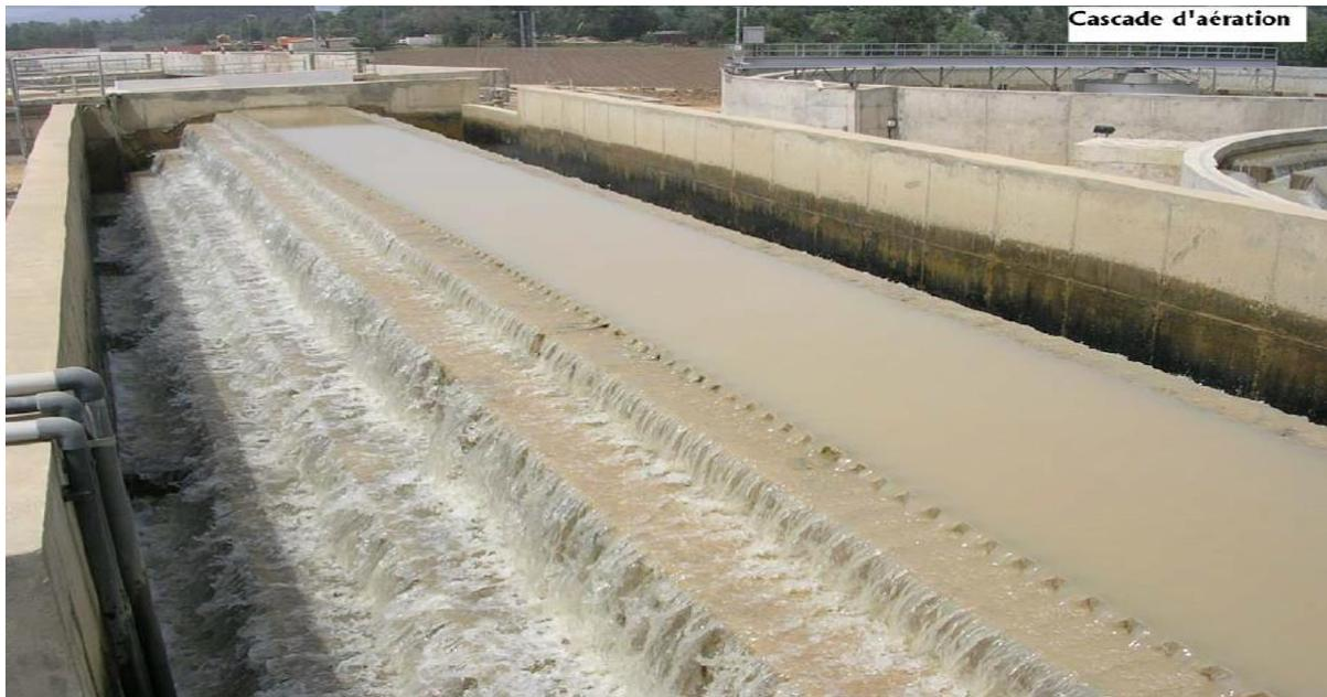
*Figure 0-2: Cascade d'aération.*
