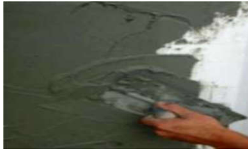
Figure I. 5. Utilisation du mortier comme enduit [2].
