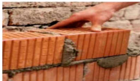
Figure I.4. Utilisation du mortier dans la maçonnerie [2].
