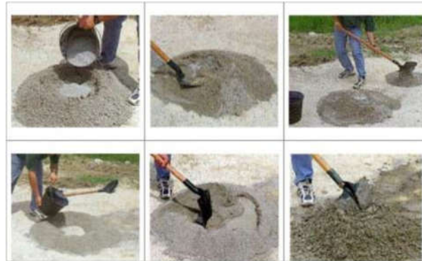
Figure I.8. Scellement d'un poteau avec un mortier [2].
