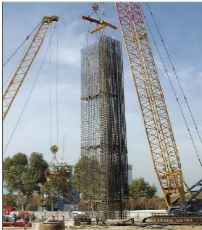
**Figure 1.12:** Mise en place d'une cage d'armature
