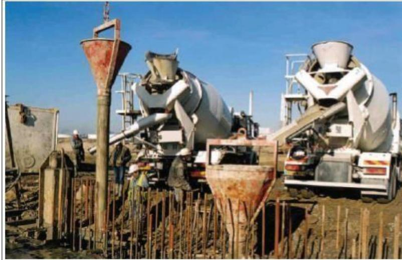
**Figure 1.13:** Bétonnage d'un panneau par deux camions
