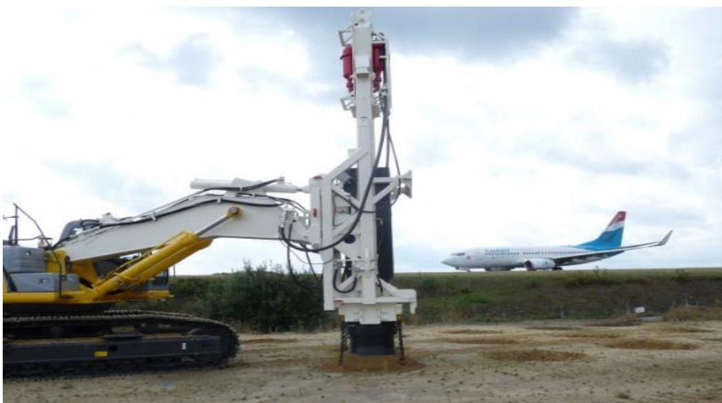
Figure I.17: Engin de réalisation de colonne ballastées pilonné (Höhenhof de l'aéroport du Findel, Killer)
