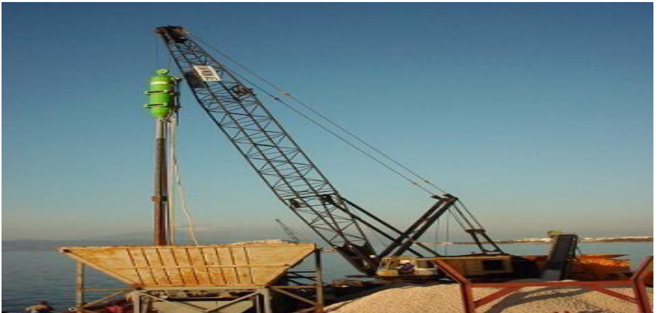
Figure I.20: Atelier de réalisation de colonnes ballastées en mer
