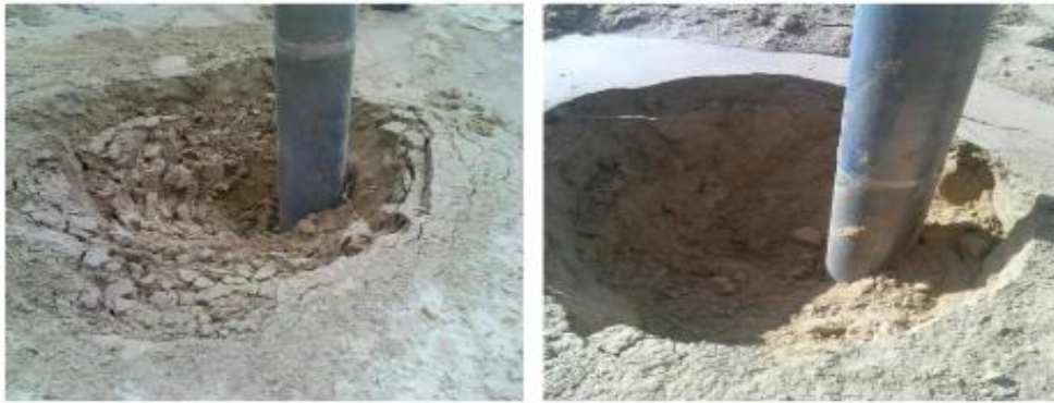
Figure I.9 : Le cône d'affaissement autour de vibreur (barrage -Harka- TUNISIE)
