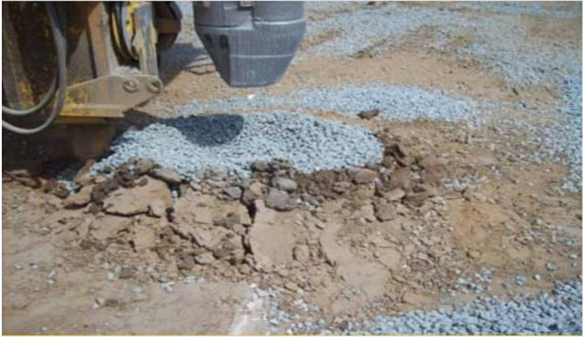
Figure I.12: finition d'une colonne par voie sèche (site : mosquée de boudouaou) (Laboratoire legeotech)
