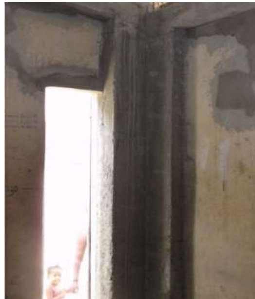
Figure II.15: Exemple de chaînages Verticaux réalisé.
