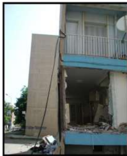
Figure I.15: Rupture de panneaux de maçonnerie intérieures et ceux des façades du RDC.
