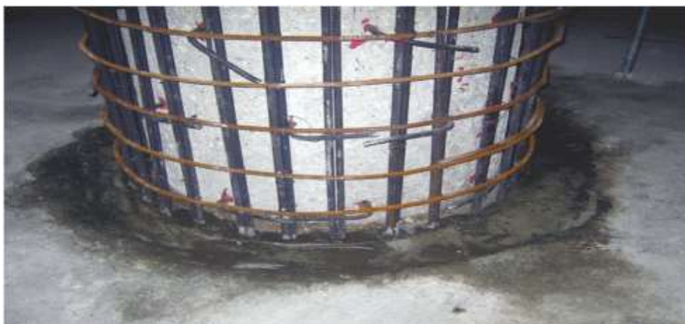
Figure III.2: Chemisage par béton armé.
