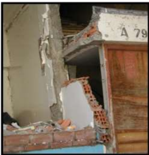
Figure I.15: Rupture de panneaux de maçonnerie intérieures et ceux des façades du RDC.
