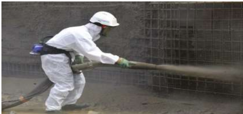
Figure III.9: Opérateur de projection en voie mouillée.
