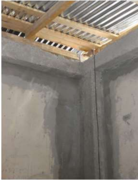
Figure II.19: Mise en place d'un chaînage supérieur Horizontal.
