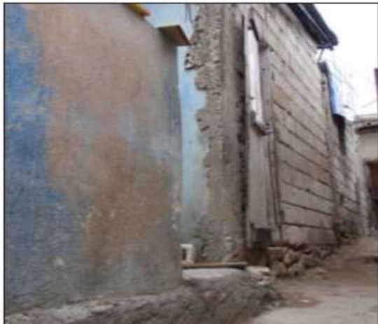
Figure II.17: Un manque de chaînage bas Horizontal.
