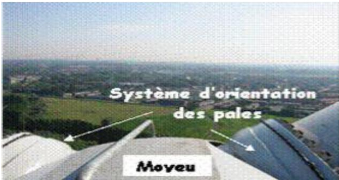
Figure II.1 système d'orientation des pales.[19]
