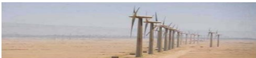
Figure I.5 La première ferme éolienne en Algérie.
