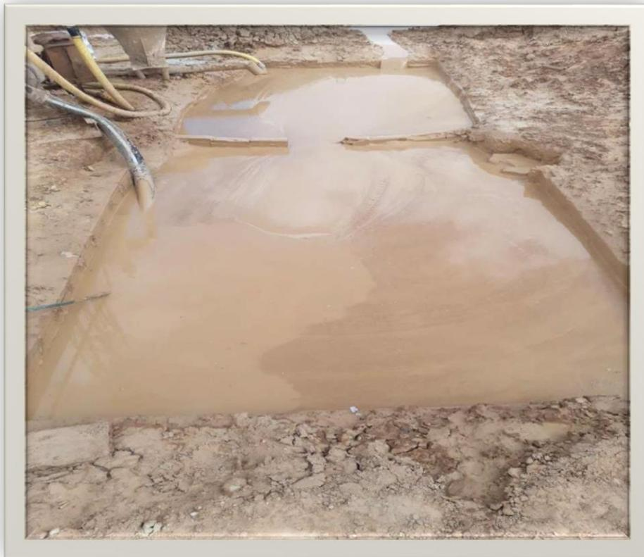
**Figure 21: Préparation de la boue de forage**
