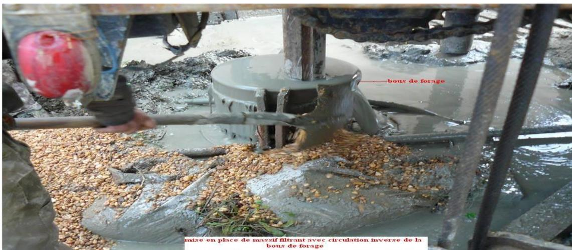
**Figure 28: Mise en place de massif filtrant**
