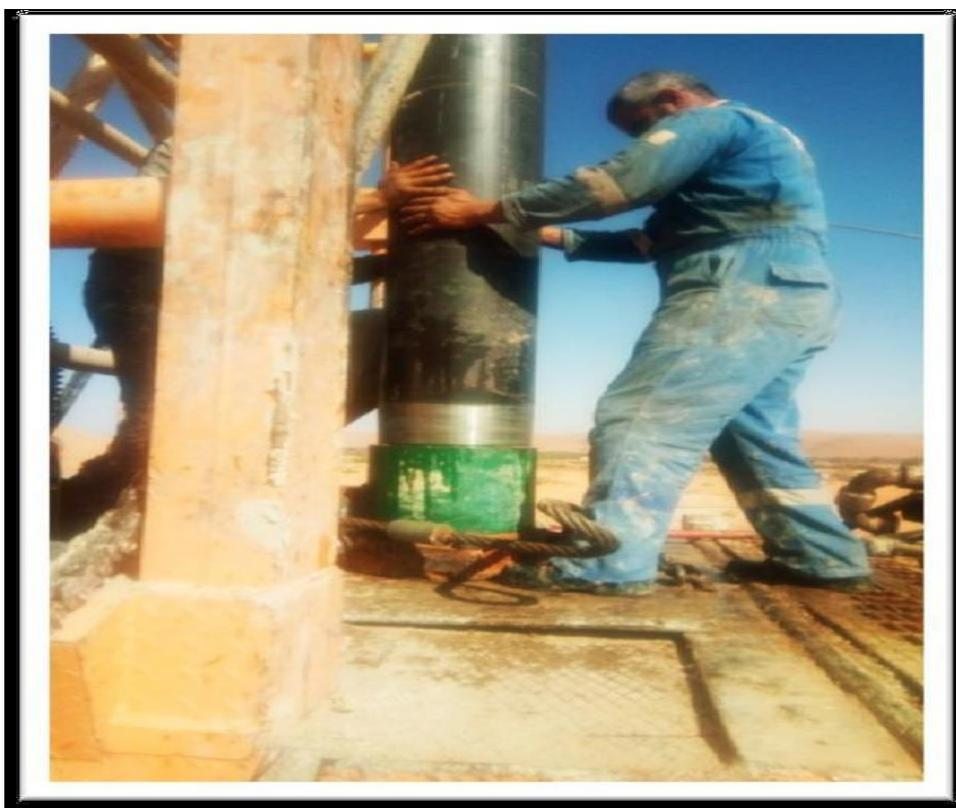
**Figure 25: L'installation des tubages**
