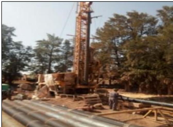
**Figure 27: Mise en place du tubage (peins et crépines)**
