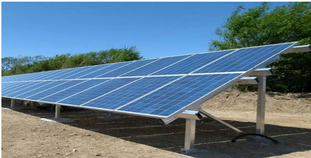
Figure (1.18) . Exemple de montage sur châssis.
