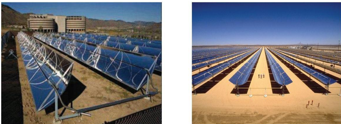
Figure. III.1: Photographe de deux installations utilisant des capteurs cylindro parabolique. [28]
