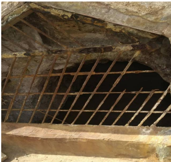
Figure II.10 : La source chaude géothermique
