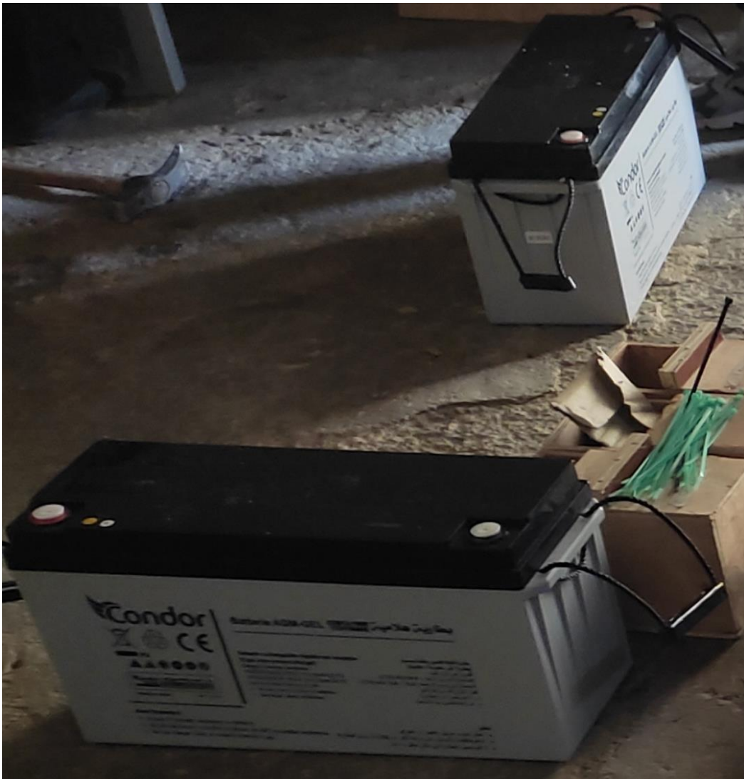
Figure 34: La batterie solaire GEL à utiliser pour les deux installations. (CONDOR)
