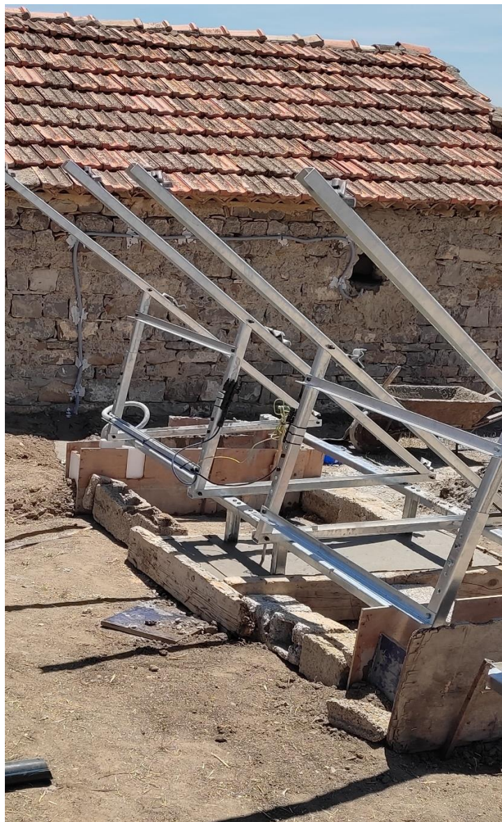
Figure 33: Le système de support simple orienté vers le sud
