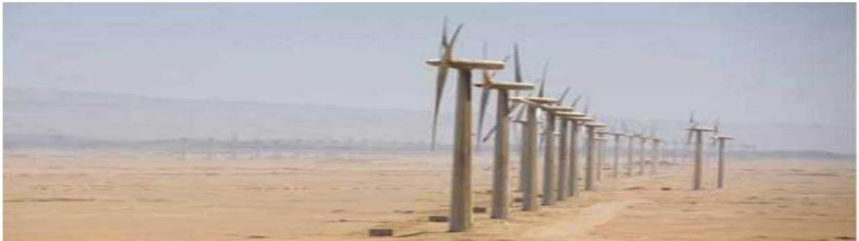
Figure I.5. La ferme éolienne à Adrar [4]
