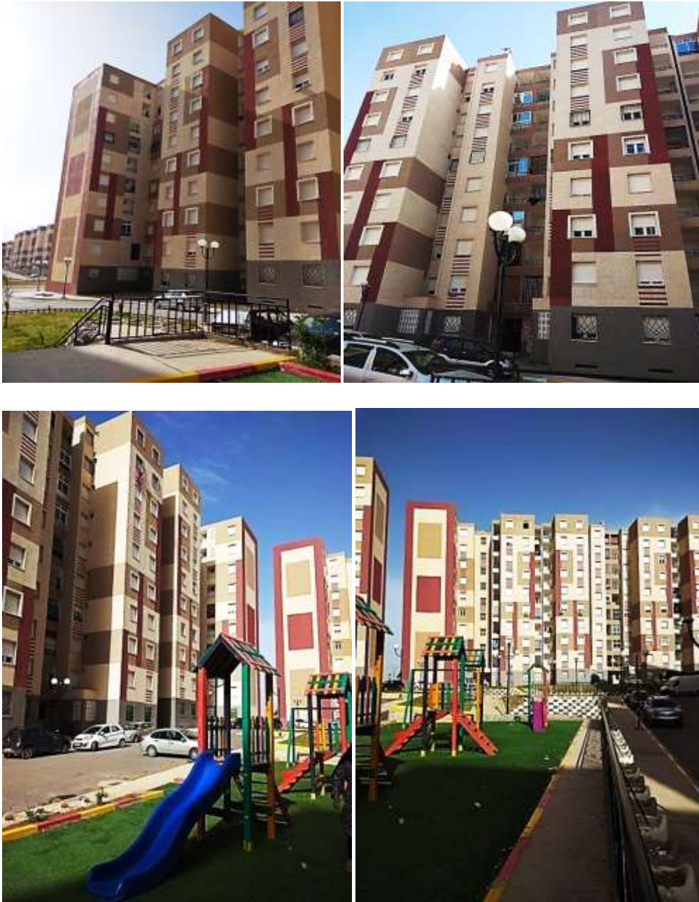
Figure IV.4. Photos prises sur le site du deuxième cas d'étude
