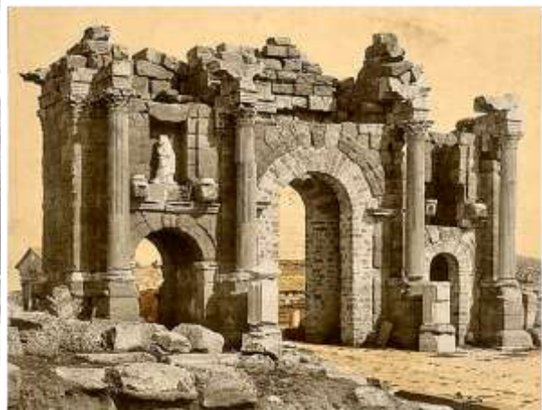
Figure II.19. Exemple de construction en Algérie avant 1830
