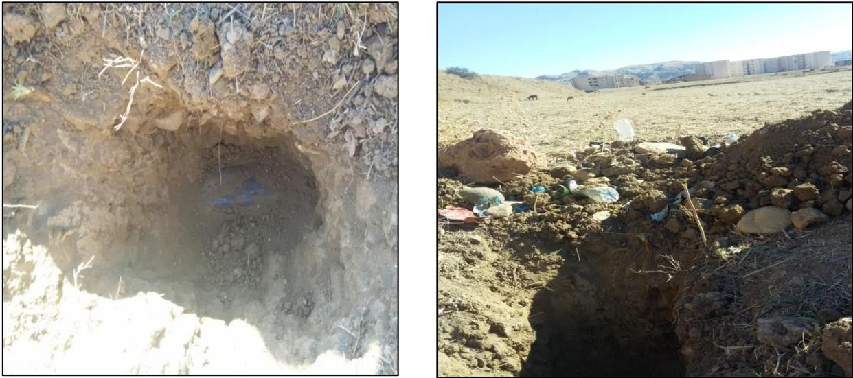
**Figure III.7 Conduite, de PEHD 160mm de diamètre et de 3 155 ml de longueur, reliant la station de traitement à la station pompage SP KRIMA. En bonne état**
