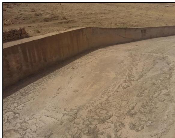
**Figure III-1 Un barrage de 10 m de hauteur au-dessus du lit mène à une retenue de 900 000 m3 à 75 % de vieillissement.**
