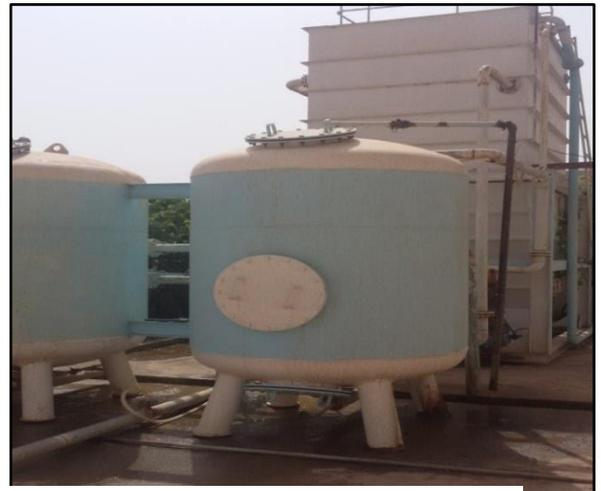
**Figure III-5 -Une station de traitement mono bloc, de 10 l/s de capacité, à proximité de barrage R'HOUB.**
