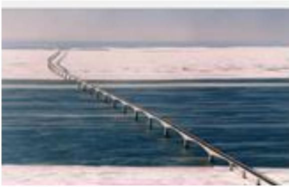
Figure II 7: Pont exposé au gel/dégel.
