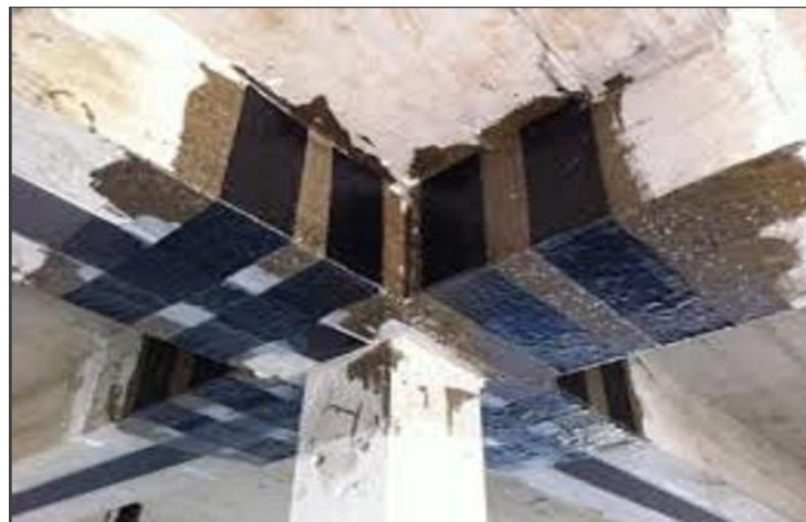
Figure II 27: Renforcement des poutres par matériaux composites.
