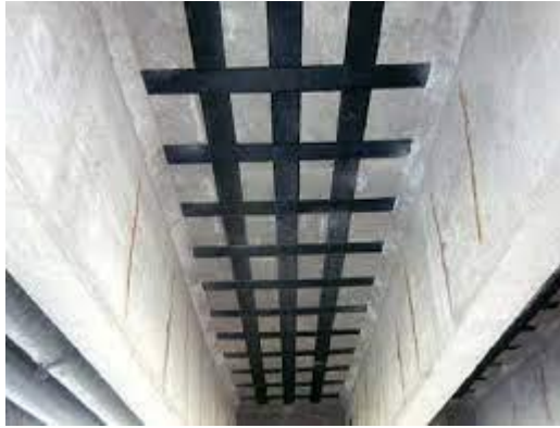
Figure II 32: poutre renforcée par composites.
