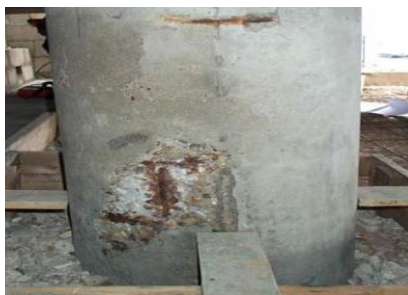
Figure II 16: Exemples de corrosion des structures en béton armé.
