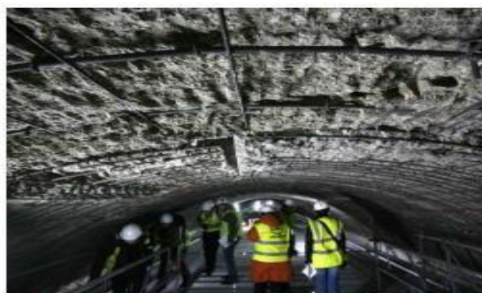
Tunnel Sous la Manche en phase de réparation à la suite de l'incendie de Septembre 2008, [Lejd, 2008].
