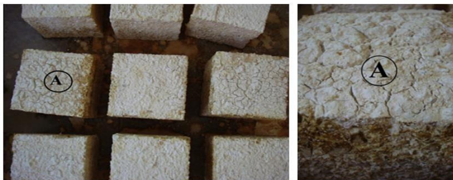
Figure II 13: Exemple de l'attaque par l'acide sulfurique dosé à 5% pour un béton ordinaire durant quatre mois.
