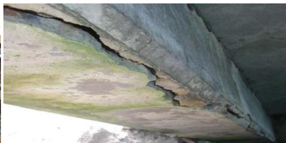
Figure II 16: Exemples de corrosion des structures en béton armé.
