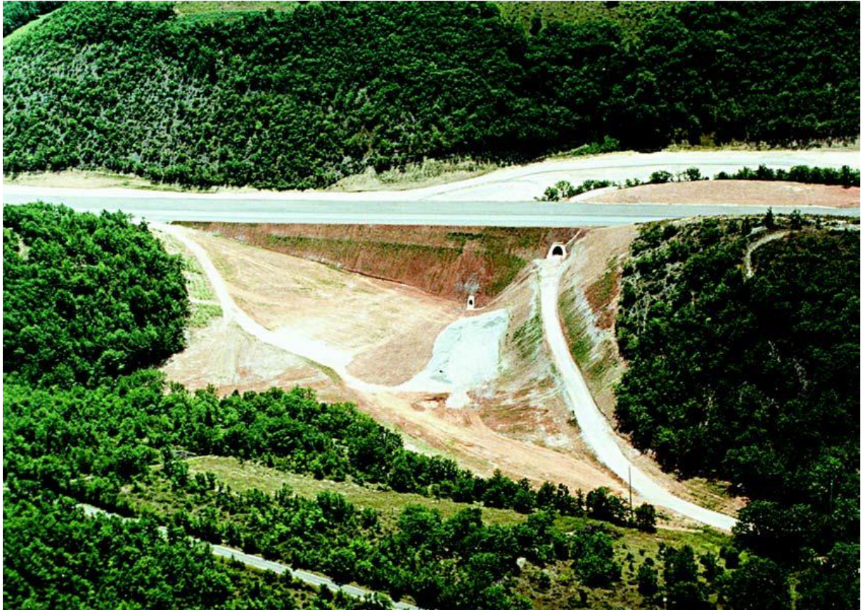
Figure 7 :Exemple d’ouvrages transversaux dans un grand remblai (Photo Guintoli).
