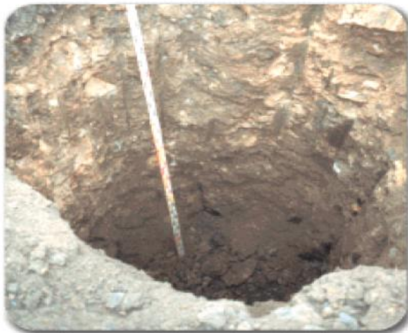
Figure 23 : Plot ballasté avant remblaiement type (Document de G.T.S®)
