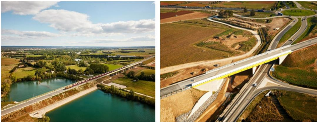
Figure 1 : Types de Remblai (ferroviaire, routier)
