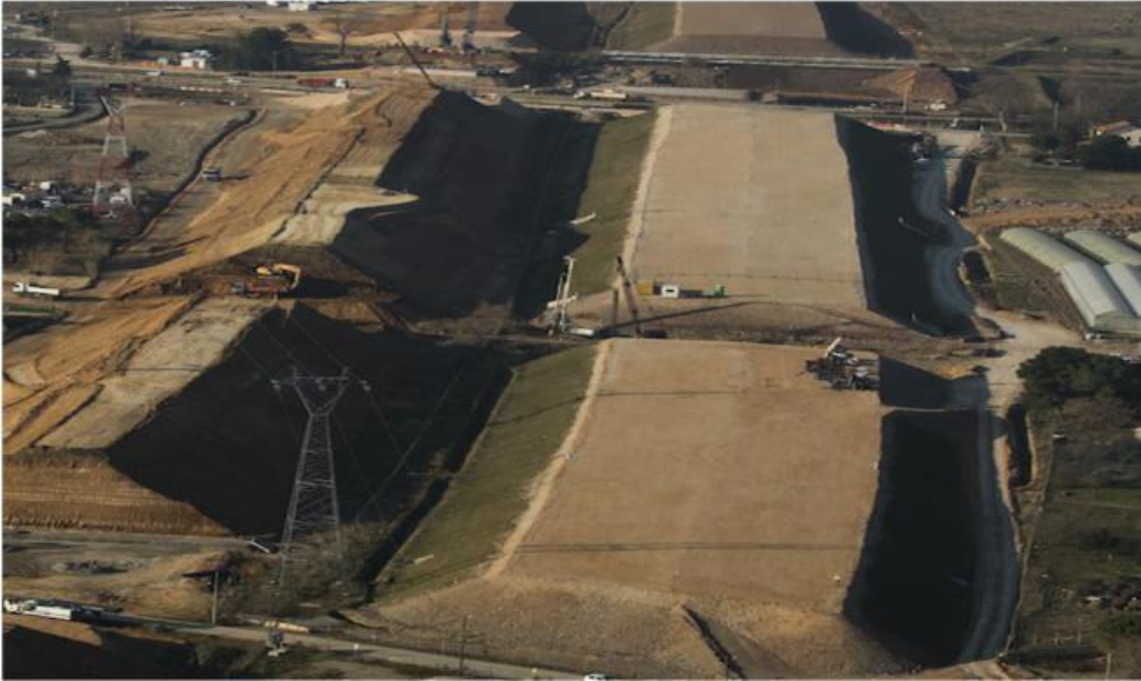
Figure 3: Remblai de grande hauteur
