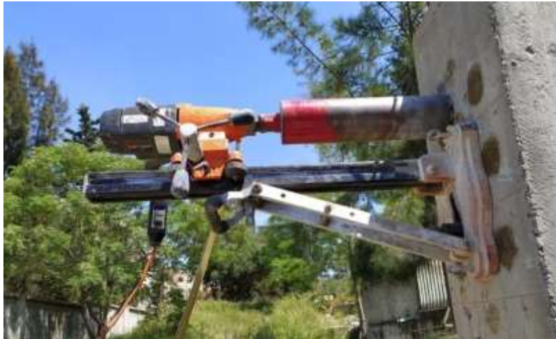
Figure 9. Mise en place d'un carottier à la surface du poteau.
