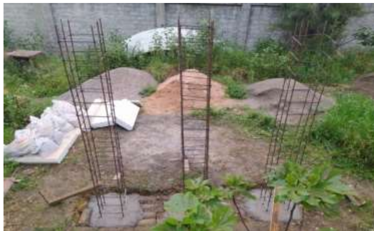
Figure 20. Ferrailage des poteaux
