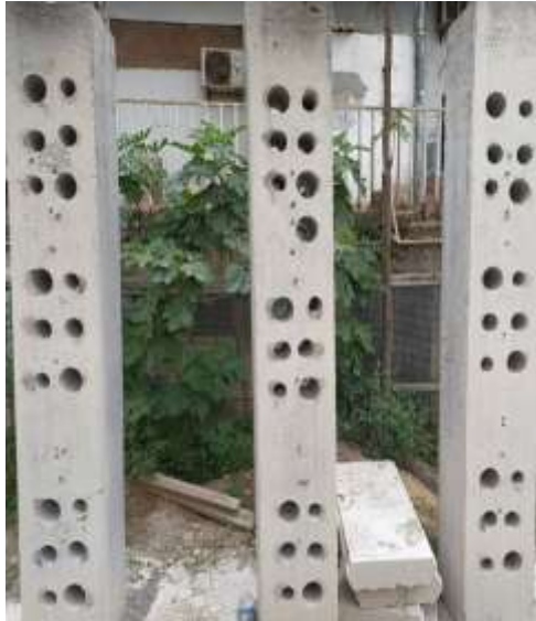
Figure 8. Poteaux après carottage
