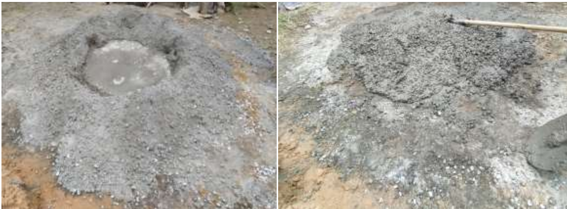
Figure 22. Mélange du béton
