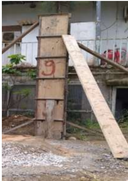
Figure 21. Coffrages des poteaux
