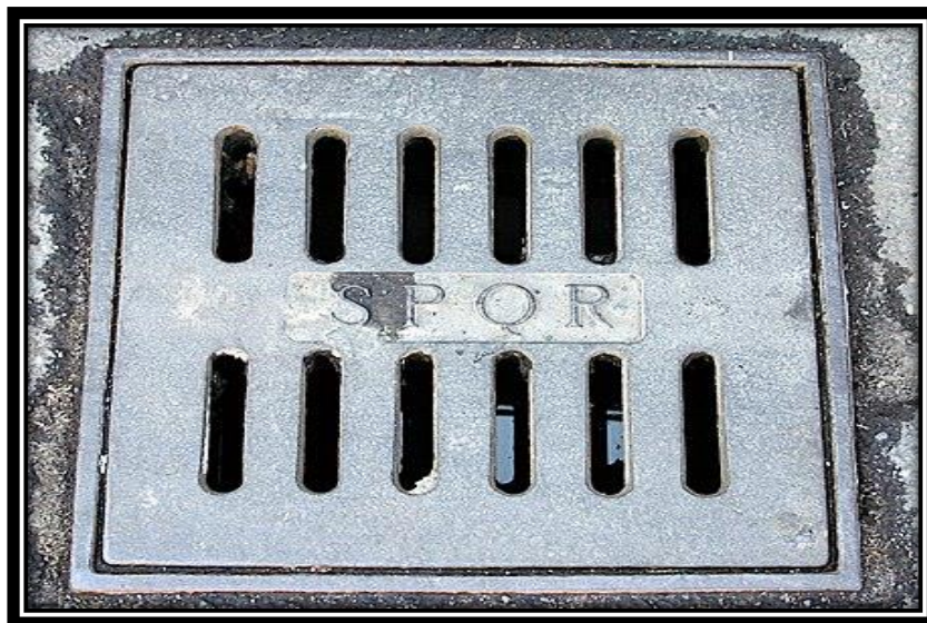
Figure I. 15: Les bouches d'égout avec grille et couronnement métallique.
